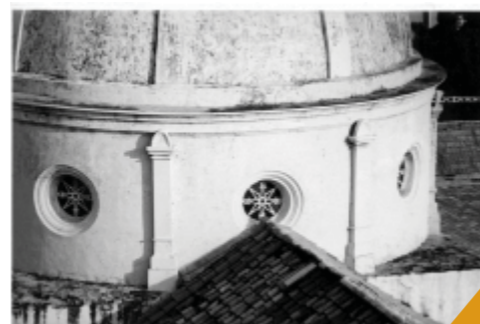
Fig. N° 5. Antigua Catedral de Maracaibo. Empalme sin resolver entre la cúpula y la cumbre del techo preexistente de las naves. Fotografías: Autor desconocido. Circa 1969. Original en el Archivo Arquidiocesano
