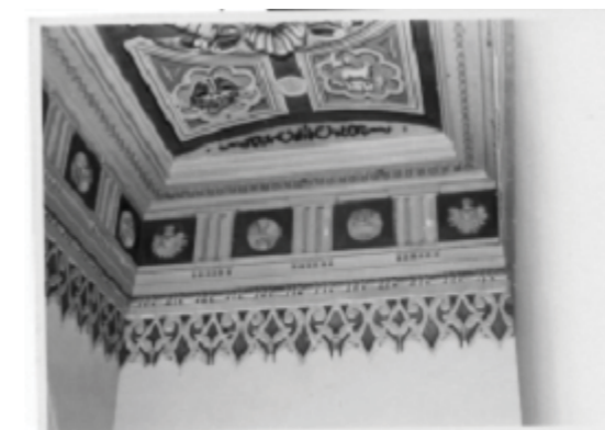
Fig. N° 7. Catedral de Maracaibo. Ornamntación en molduras de yeso y pintura al fresco en la Capilla testera lateral sur, dedicada al Santísimo Sacramento. Fotografías: Autor desconocido. Circa 1969. Original en el Archivo Arquidiocesano
