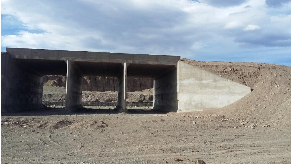
Obras en proceso sobre la ruta de acceso al sitio
