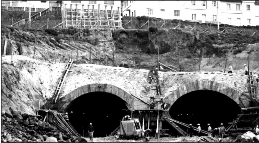
Figura 2: Trabajos en el túnel de San Roque, en Quito, 1975.
