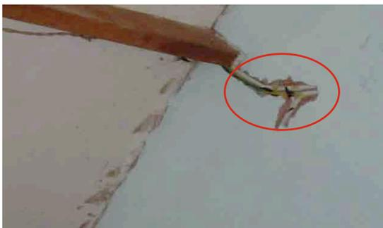
**Foto 27:** Ingreso de los cables eléctricos con protección de poli tubo y salida sin tubo.
