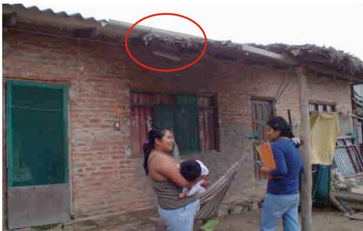
**Foto 26:** Unión de techos cubierta de fibrocemento con canaleta con techo de galería improvisada con techo de palmas secas
