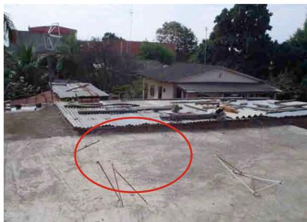
Losa alivianada unida a una cubierta con calamina metálica, se observan las filtraciones de agua
