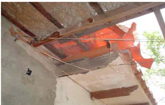
**Foto 28:** Ingreso de los cables eléctricos sin ningún aislamiento.
