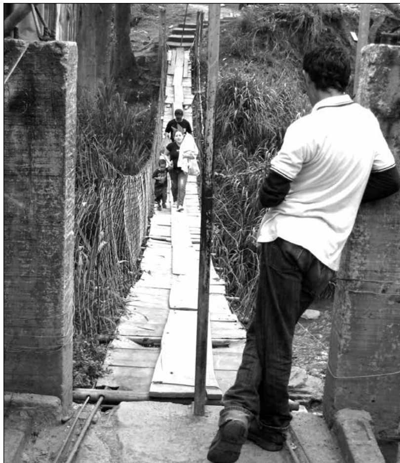
Fotografía N° 6 Puente en su estado actual
