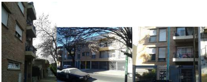
Imagen 29: Fotos de frente de hormigón y ladrillo descubierto en Complejos Estomba 1148, Giribone 1330 y Giribone 840. PRTEXAu3. CABA. 2013
