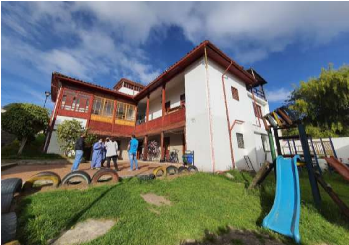
Parte posterior de la edificación donde estaban los servicios. Fotografía del autor.
