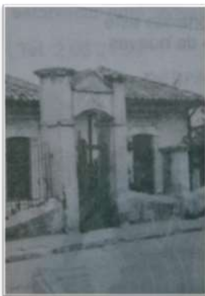
Imagen 13. Casa en abandono, años 70. El portal de entrada estaba con parales y soportes para que no se cayera, no tenía el refuerzo del dintel horizontal actual. Su puerta de madera con forja que en algún momento del tiempo desapareció.
