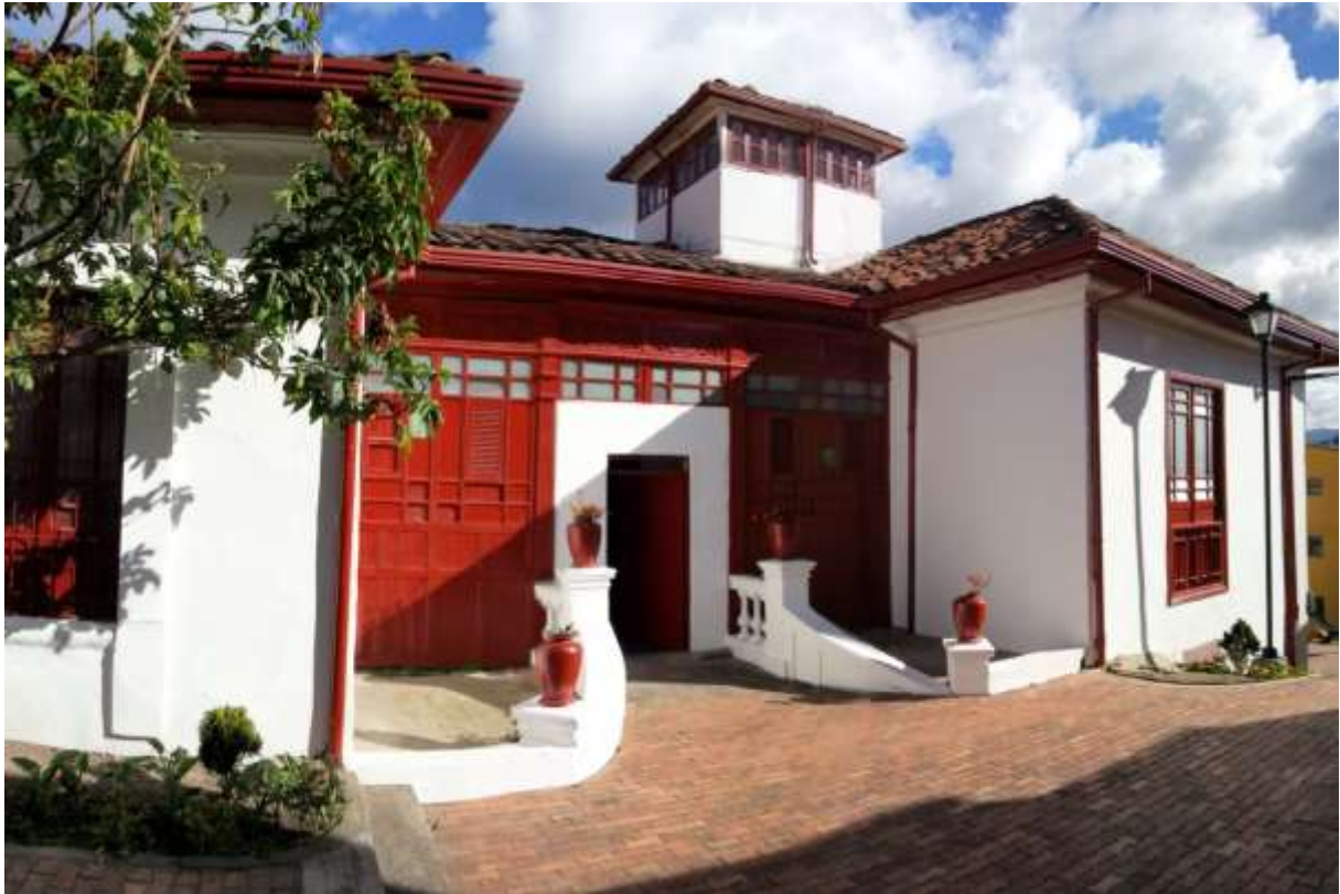
Fachada lateral de entrada de carruajes y por escalera en abanico. Fuente: Amparo Cuellar Velásquez
