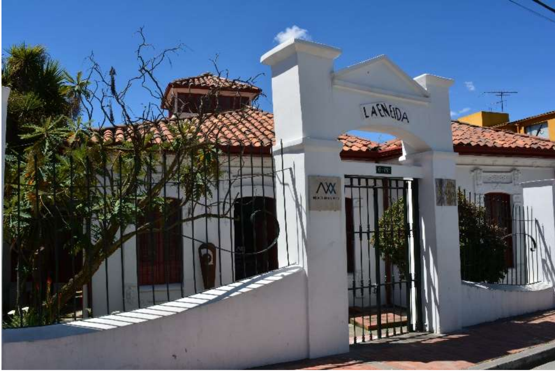
Fachada principal sobre lo que fue la Vía Nacional a Ubaque. Fuente: Museo del Vidrio.
