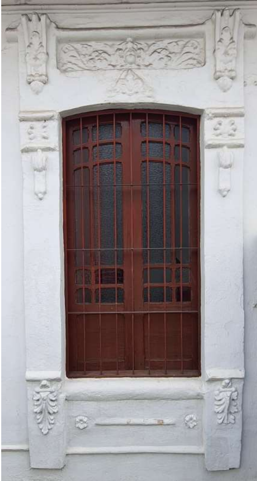
Detalle del arquitrabe con las decoraciones mencionadas en la fachada principal
