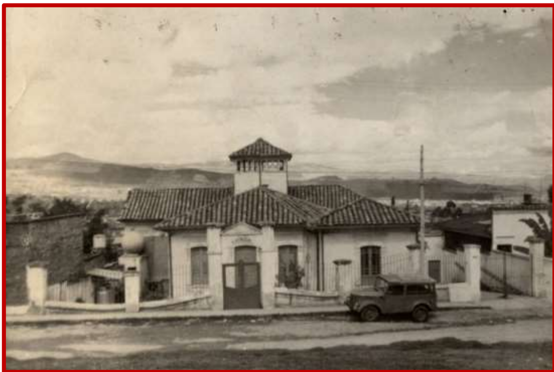
Antejardín de la quinta, transformado con tanques de gas y agua. Fuente: Gabriel Mendoza de Echeverría
