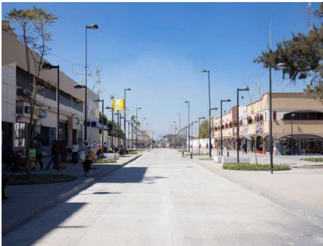
Imagen 12. Fotografía Sedatu. Ejemplo de luminarias dobles para iluminar arroyo vial y sendero peatonal, Chalco, Estado de México, febrero de 2021
