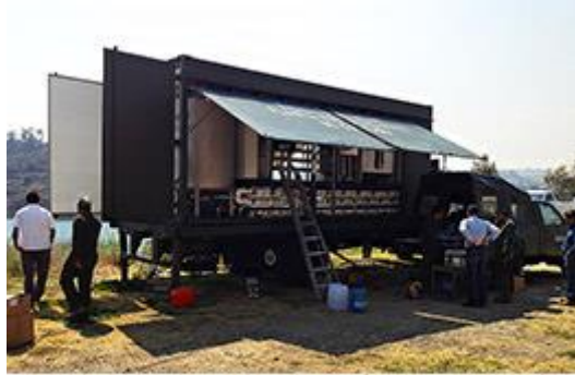
El Instituto Mexicano de Tecnología del Agua diseñó y supervisó la construcción de un prototipo de planta potabilizadora móvil.
