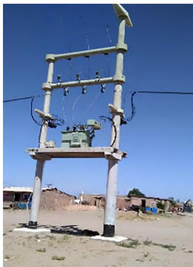
**Figura 7. Línea Media Tensión (transformador).** Fuente: *elaboración propia*
