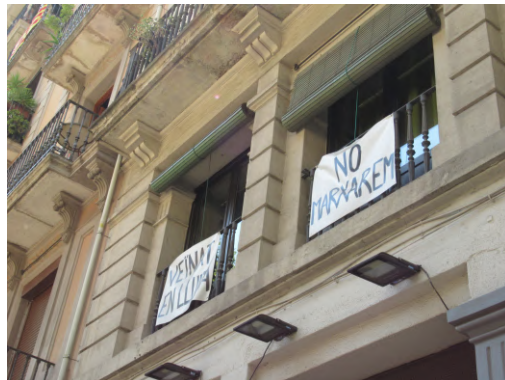
Fig. 10/ Carteles colgados en algunos edificios: “Vecindario en lucha” y “No nos iremos”.
