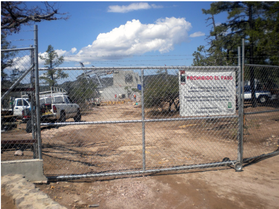
Imagen 11. Sitio de construcción del teleférico en Divisadero (Fotografía: Horacio Almanza, 2010).
