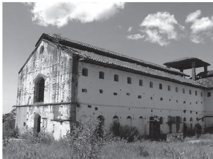
Fig. 10. Panoptico. Vista esterna di una crociera prima dei restauri (agosto 2006).
