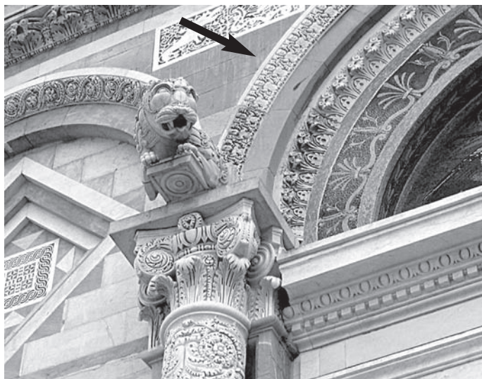
Figg. 1, 2. Duomo di Pisa, facciata principale. Evidenti gli elementi delle ghiere sostituiti nel corso dei restauri ottocenteschi. Foto tratta dall'archivio personale.
