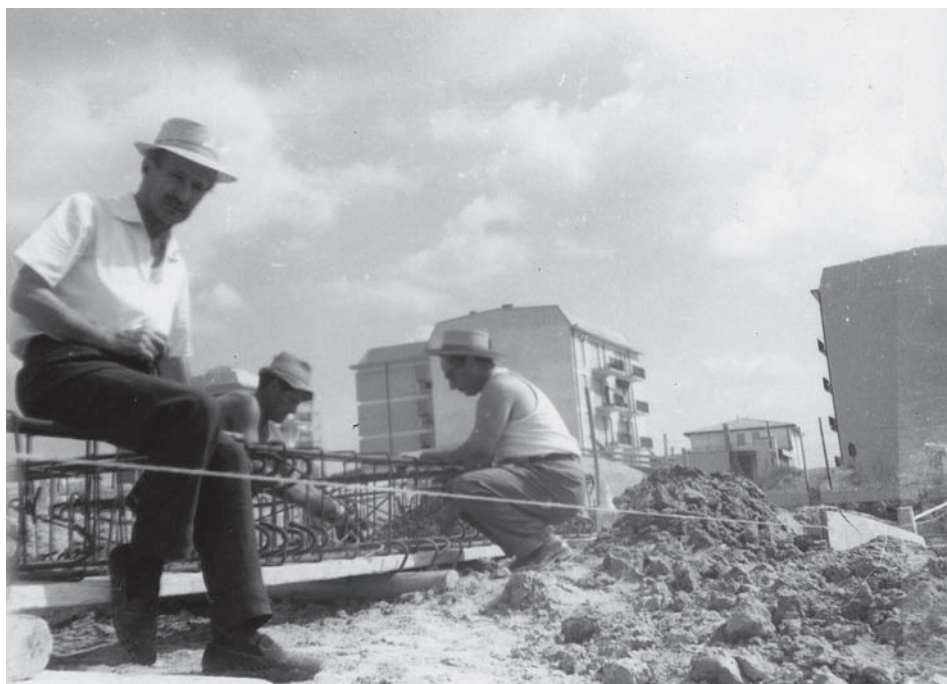
Fig. 1. Foto di cantiere. Nella persona seduta sull'armatura di una trave è stato riconosciuto Quirino De Giorgio. (Archivio MART, Fondo archivistico di Quirino De Giorgio, neg. Deg_S2_07.tif).
