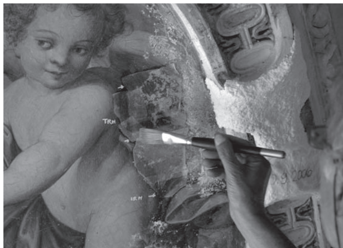
Fig. 11. Biasca (TI), Chiesa dei SS. Pietro e Paolo, sperimentazione di nanocalci per il consolidamento della pellicola pittorica.
