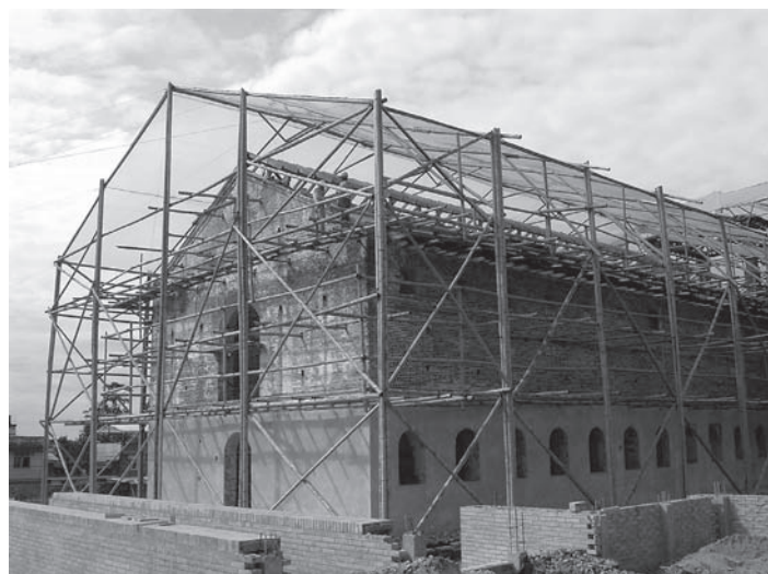
Fig. 11. Panoptico. Vista esterna durante i lavori di restauro (agosto 2007).
