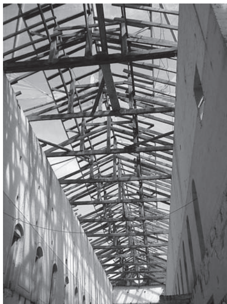
Fig. 6. Panoptico. Copertura in legno durante i lavori di restauro (agosto 2007).
