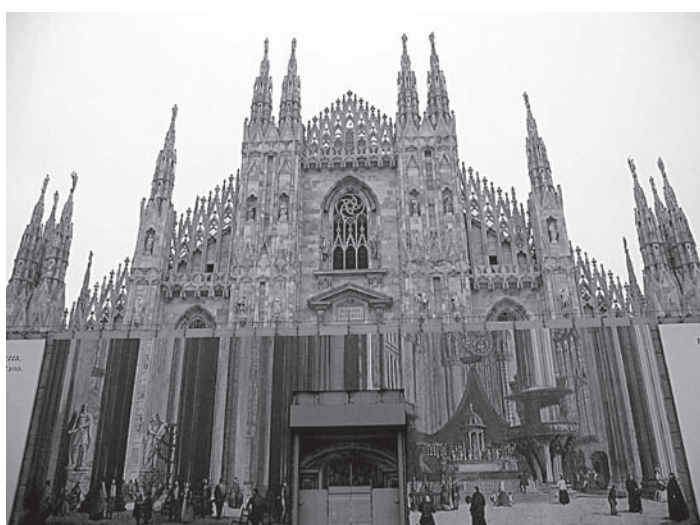
Fig. 3. Duomo di Milano, facciata principale. La parte alta della cattedrale è stata da poco restaurata e gli elementi più chiari, ben evidenti anche da una visione a distanza, sono quelli sostituiti nel corso degli ultimi lavori. Foto tratta dall'archivio personale.
