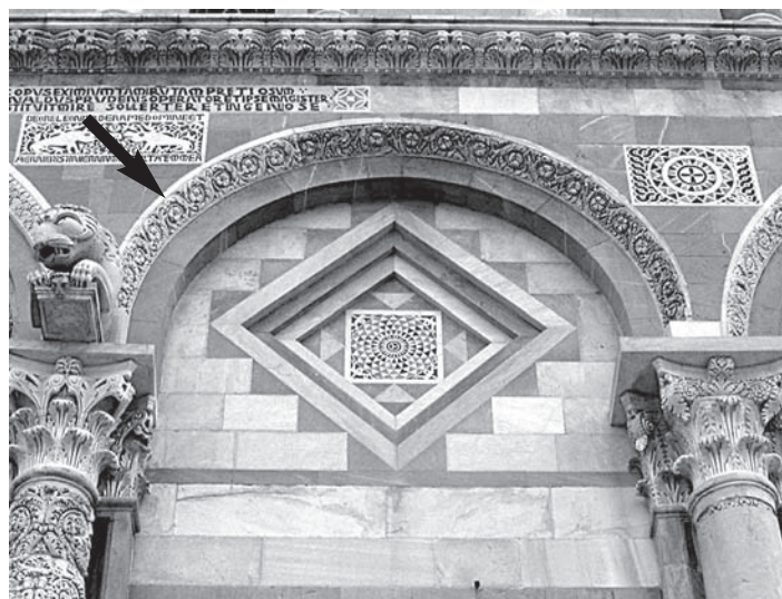
Figg. 1, 2. Duomo di Pisa, facciata principale. Evidenti gli elementi delle ghiere sostituiti nel corso dei restauri ottocenteschi. Foto tratta dall'archivio personale.
