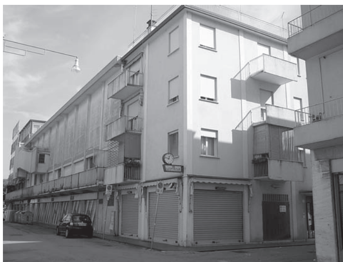
Fig. 8. Prospetto su via Millosevich.
