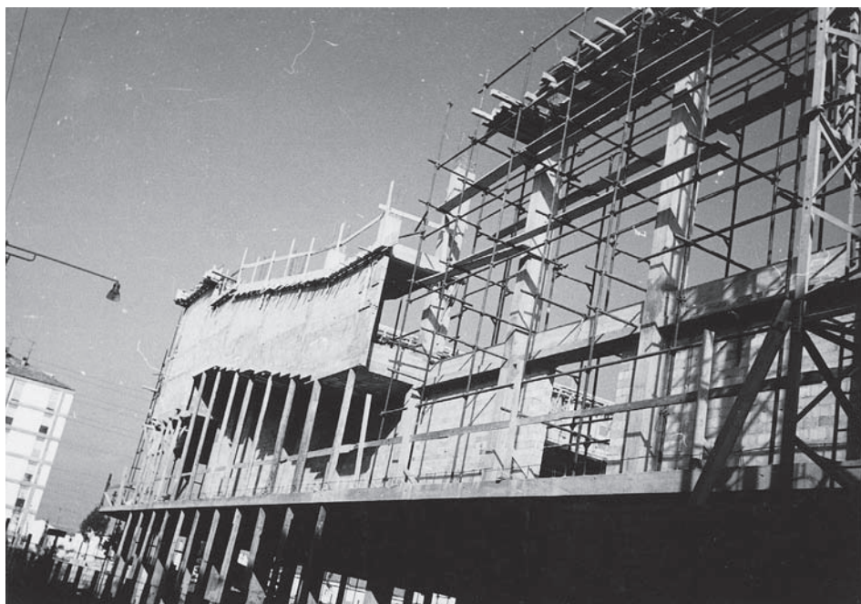
Fig. 13. Foto di cantiere. Costruzione della struttura della galleria. (Archivio MART, Fondo archivistico di Quirino De Giorgio, neg. Deg_S2_14.tif).
