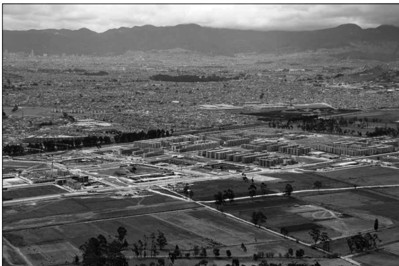
Fotografía N° 1 Vista aérea de la construcción de la primera etapa del Macroproyecto Ciudad Verde
