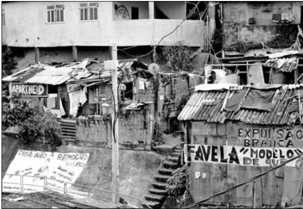
Figura 2. Casas en la zona más antigua de la favela Santa Marta, con pancartas contra la amenaza de remoción que tienen bajo la justificación de estar ubicadas en zonas de riesgo.
