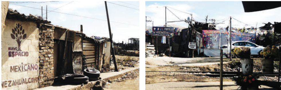
Figuras 12.13 y 12.14. Izquierda, asentamiento irregular sobre la banqueta; derecha, asentamientos y vías del ferrocarril
