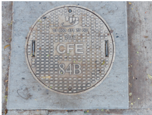
Figura 13.13. Registro de la Compañía Federal de Electricidad en una banqueta
