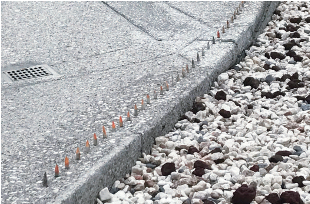
Figura 11.16. Pinchos de metal instalados entre la franja de tránsito peatonal y la franja de equipamiento
