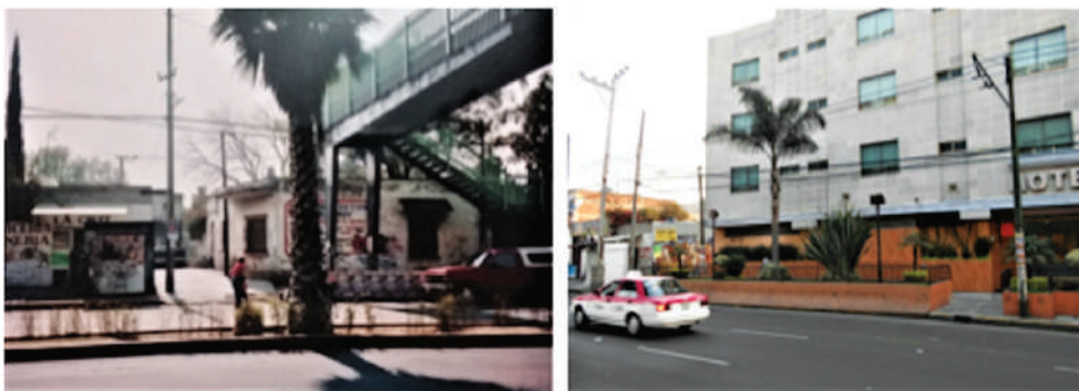
Figura 4.10. A la izquierda, el puente peatonal (1995), a la derecha, las jardineras del hotel Pazos, construida con la base del puente (2018).
