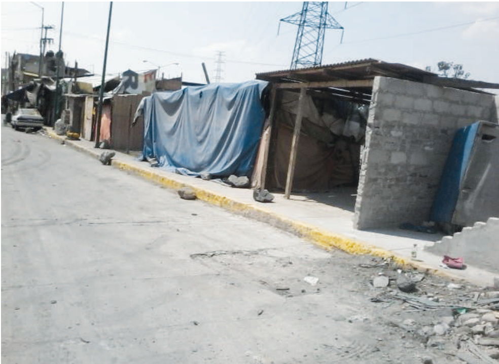
Figura 12.16. Construcción irregular sobre la banqueta federal, San Agustín
