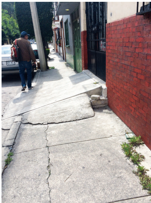
Figura 13.24. Rampa de estacionamiento, colonia Roma Sur
