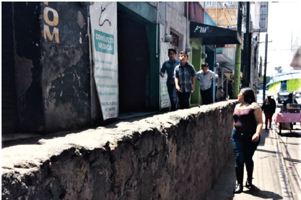
Figura 4.5. El paso a desnivel elevado
