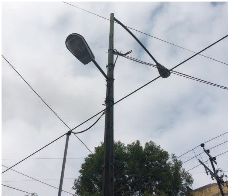
Figura 7.3. Iluminación doble para el arroyo vehicular y la banqueta. La segunda, favorece la camionabilidad nocturna, en particular para las mujeres (colonia Roma Sur)
