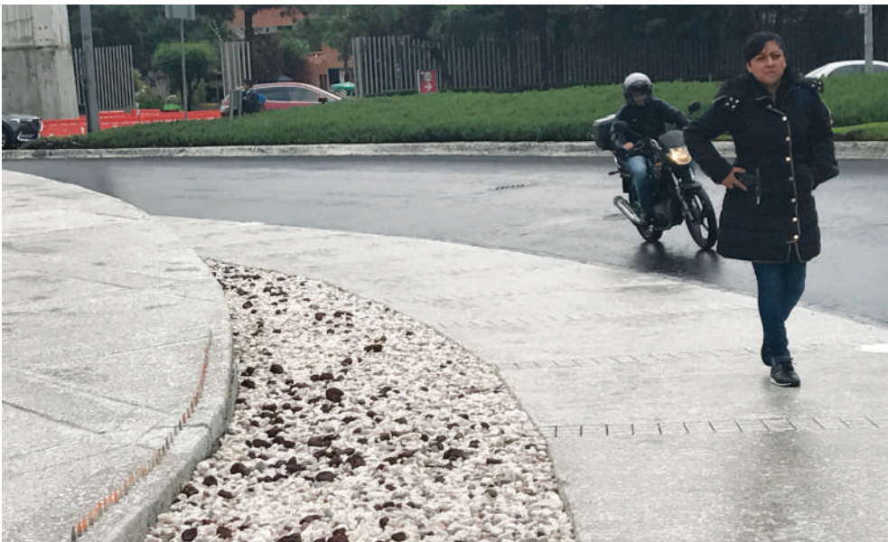
Figura 11.2. Banqueta contigua al edificio Calakmul
