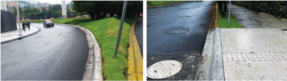
Figura 11.6. Franja de guarnición y coladera pintadas de color gris claro, Santa Fe
