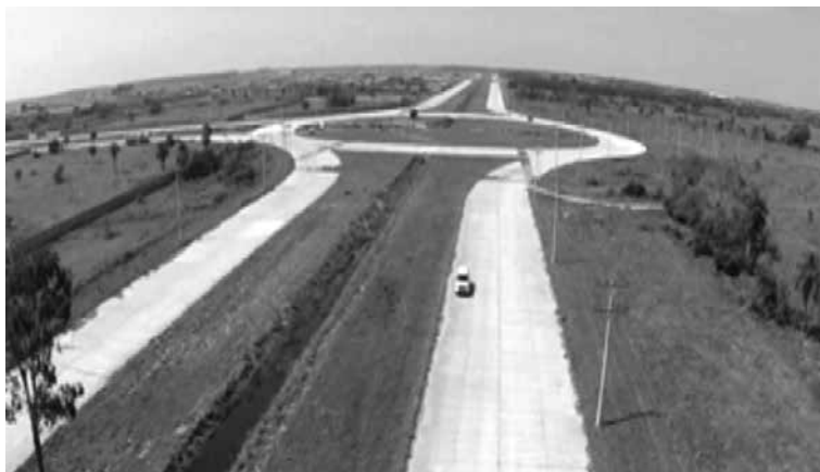
Foto 1: Vías pavimentadas del parque industrial latinoamericano
