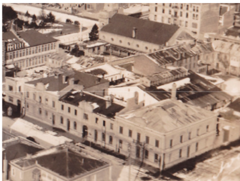
FIG. 3 / Fotografía Histórica de la Ex – Cárcel de Punta Arenas y Edificios de Gendarmería y Casa del Juez
