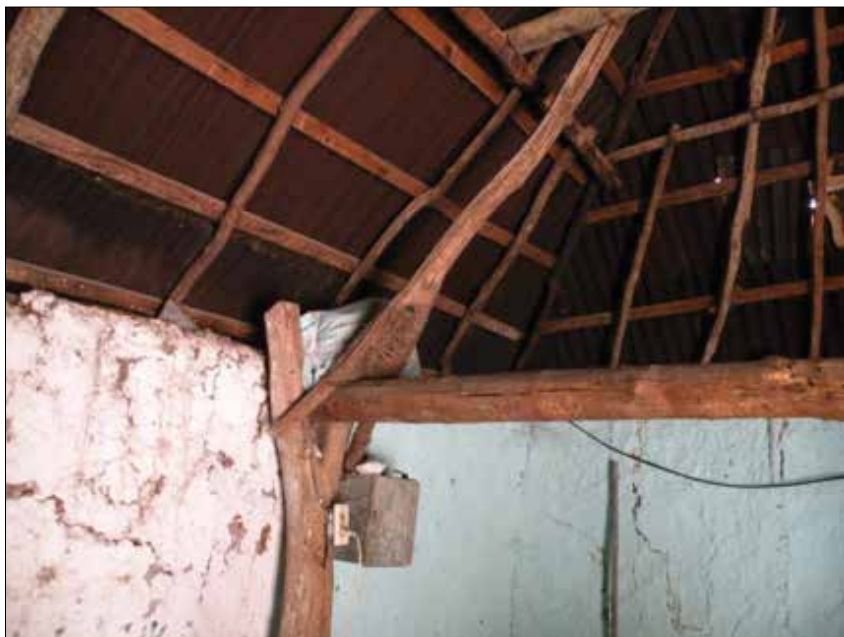
FIGURA 10. Estructura del techo de una casa en Cacalchen que resistió al Huracán Isidore (foto: J. A.).
