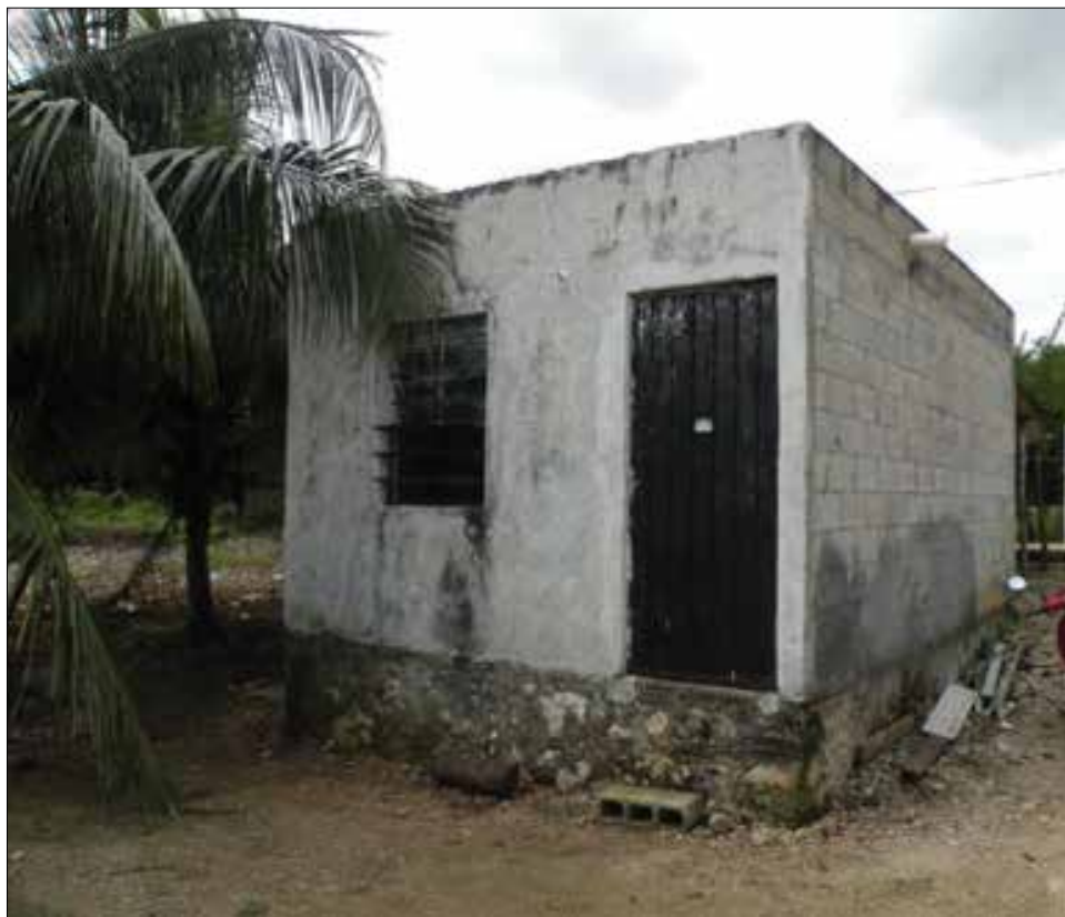
FIGURA 7. Pie de casa tipo del Programa FONDEN con 4 x 6m en Cacalchen (foto: J. A.).
