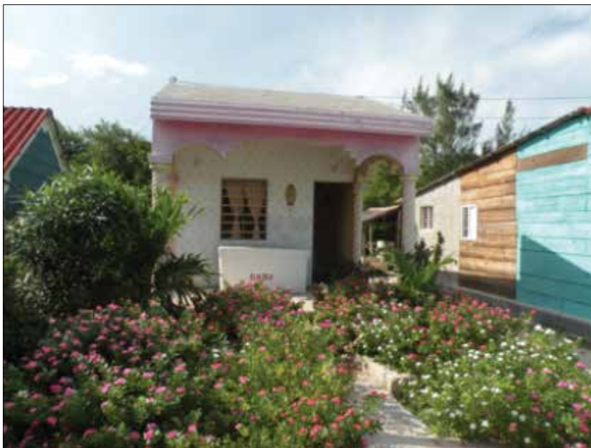
FIGURA 19. Casa del Programa FONDEN transformada por el beneficiario (foto: J. A.).
