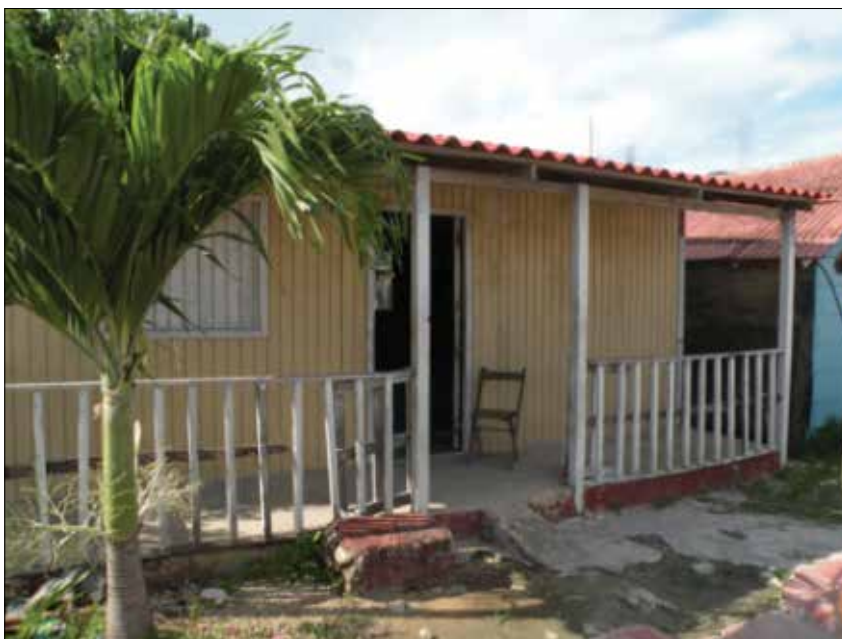
FIGURA 20. Casa construida con el sistema balloon-frame (foto: J. A.).
