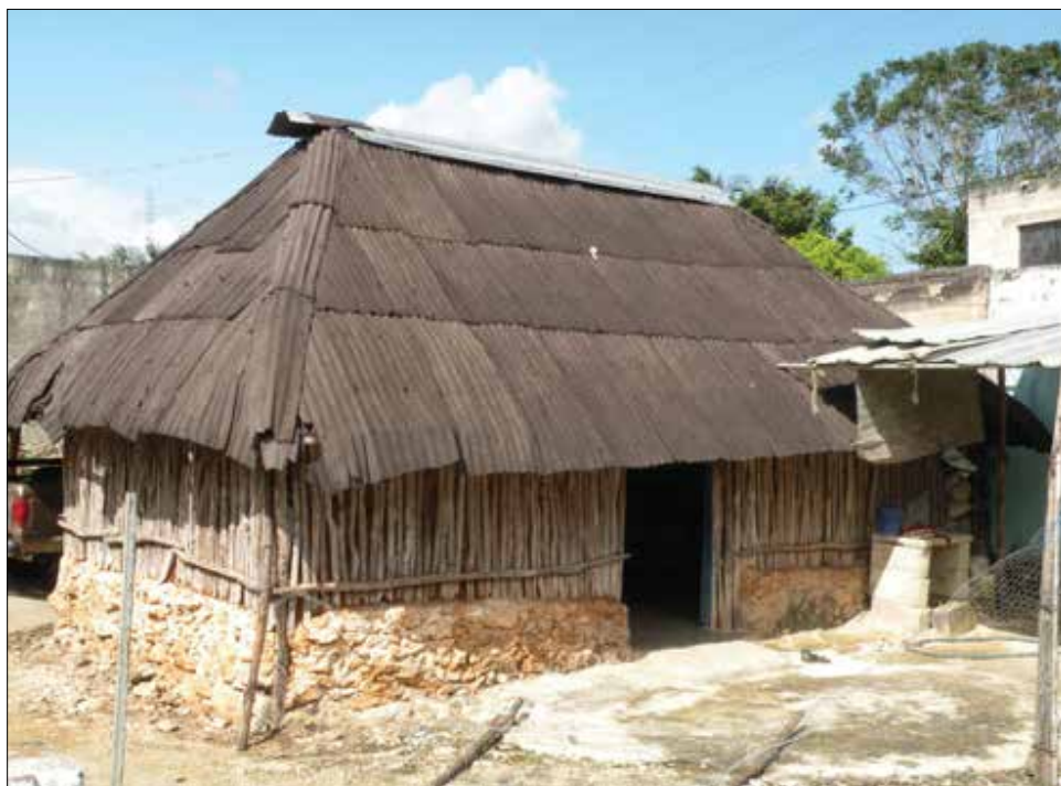
FIGURA 3. Casa maya en Cacalchén con techo de láminas de cartón (foto: J. A.).
