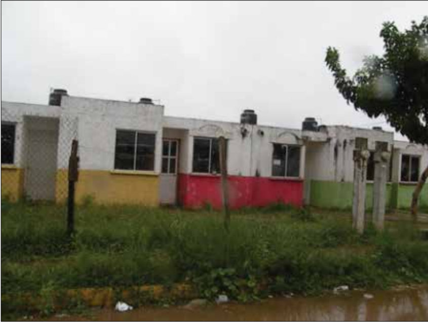
FIGURA 33. Viviendas desocupadas en el Fraccionamiento Ciudad Bicentenario (foto: J. A.).
