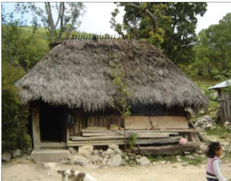
FIGURA 23. Cocina de humo hecha de horcones y techo de palma en San Martín de las Palmas (foto: J. A.).
