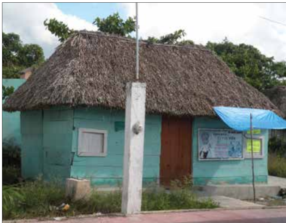
FIGURA 5. Casa de madera con techo de huano en San Felipe (foto: J. A.).
