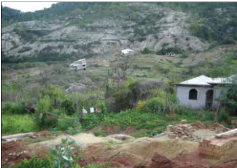
FIGURA 39. Zona erosionada en Miltiltongo, Oaxaca (foto: J. A.).
