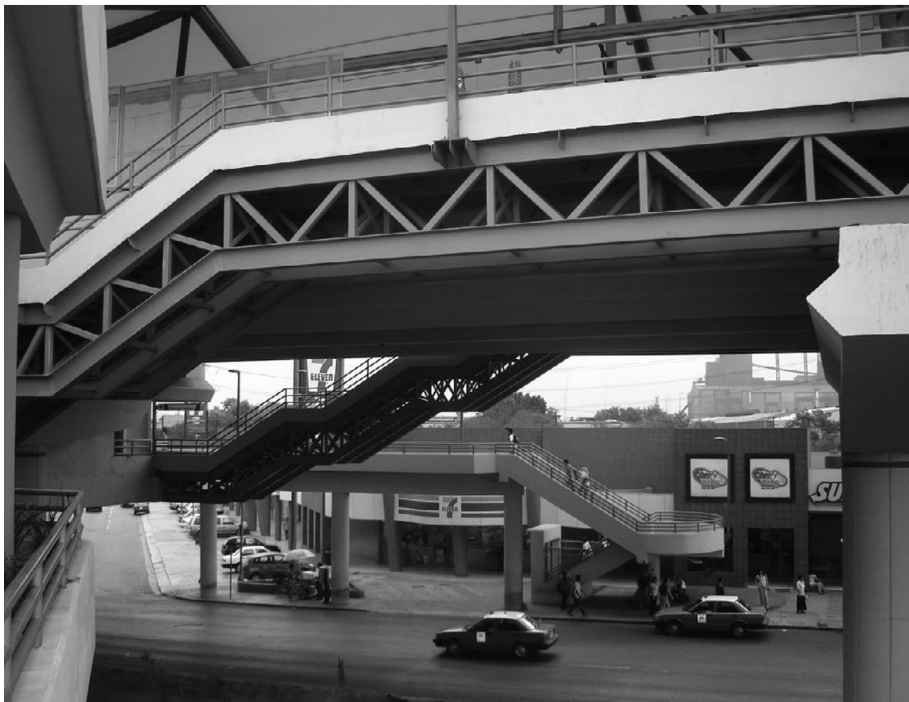
Avenida Universidad. Estación Metro UANL, San Nicolás, NL. Foto: Arturo Villa.
