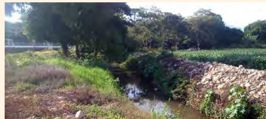
Acequia en la margen derecha del Guatapurí, entre el río y los barrios informales.
