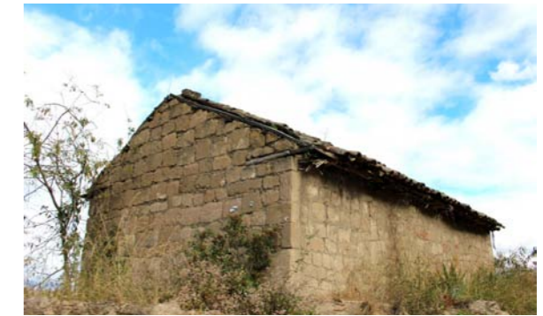
2. Provincia Pichincha. Cantón Pujilí. Sector Collas S 0°56'26,67" W 78°42'32,43"
