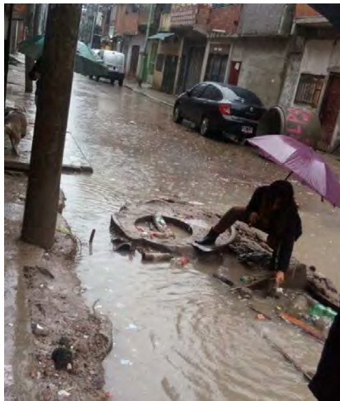
Figura 11. Cámara con descarga cloacal frente a la Manzana 22 aproximadamente a la altura de la Casa 80 sin tapa. Durante la lluvia el tirante líquido alcanzó una altura de aproximadamente 1 metro. La ausencia de tapa, cercado o vallado perimetral sumado a la presencia de casi 1 metro de tirante líquido pone en riesgo la salud y la integridad física de los vecinos y de quienes circulan por la vía pública.
