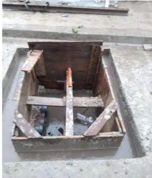
Figura 11. Cámara con descarga cloacal frente a la Manzana 22 aproximadamente a la altura de la Casa 80 sin tapa. Durante la lluvia el tirante líquido alcanzó una altura de aproximadamente 1 metro. La ausencia de tapa, cercado o vallado perimetral sumado a la presencia de casi 1 metro de tirante líquido pone en riesgo la salud y la integridad física de los vecinos y de quienes circulan por la vía pública.
