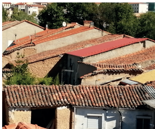
FIG. 2/ Antiguos corrales. Arquitectura tradicional en Cabañales.
