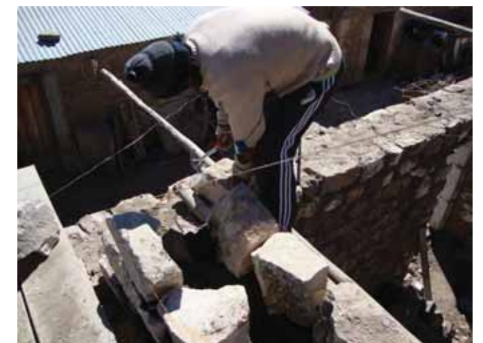
Avance de obra
