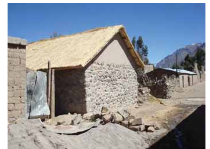
Avance de obra
