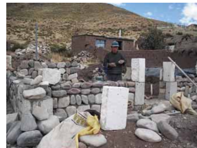
Avance de obra
