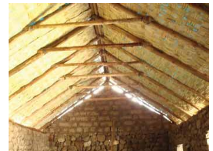
Detalle de cobertura
