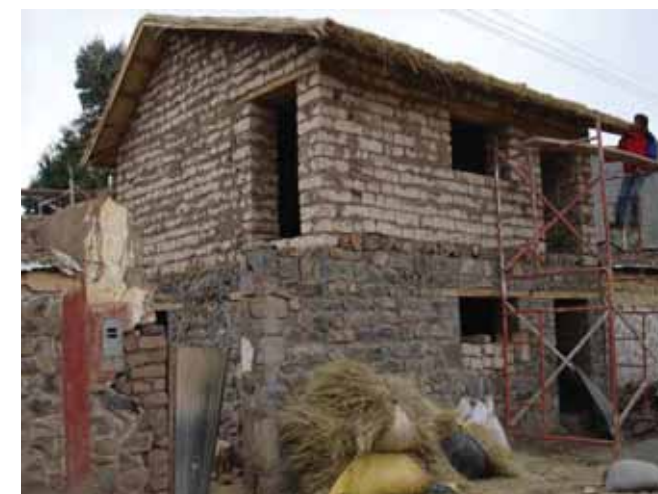
Avance de obra
