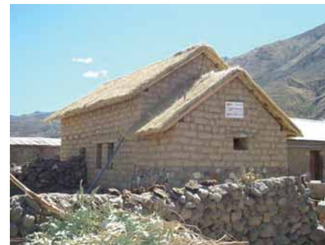
Avance de obra
