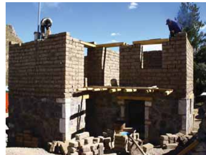
Avance de obra
