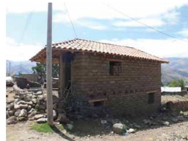
Avance de obra
