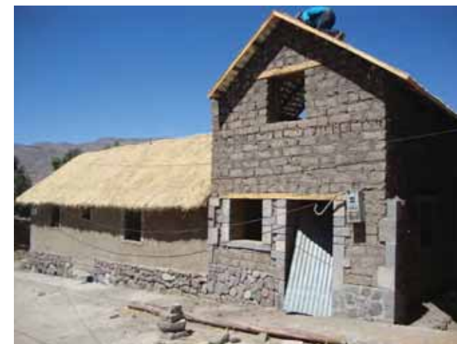
Avance de obra
