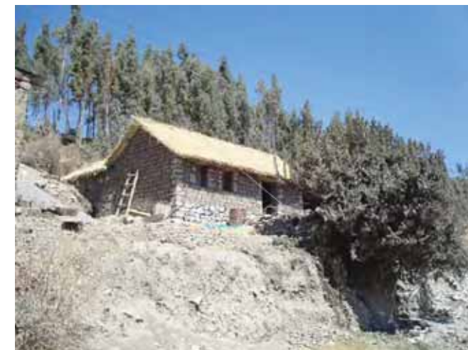
Avance de obra
