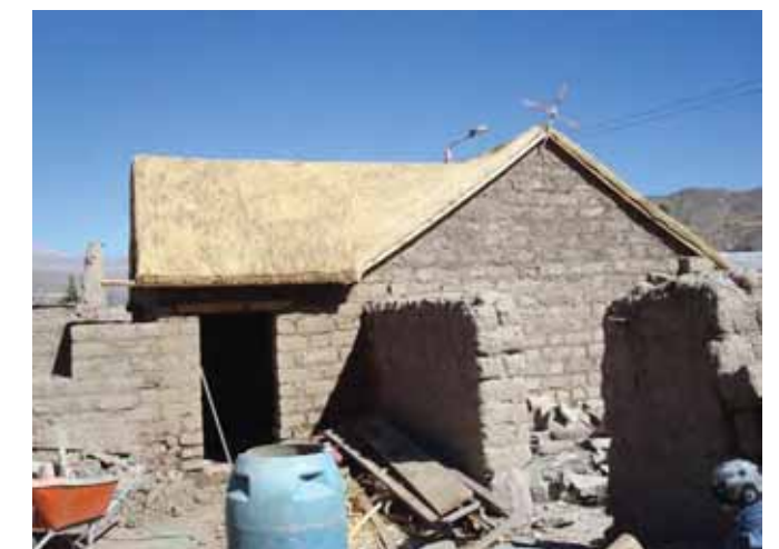
Avance de obra
