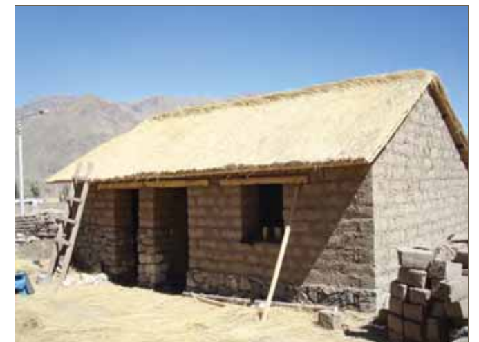
Avance de obra
