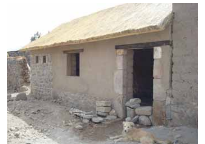
Avance de obra
