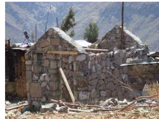
Avance de obra
