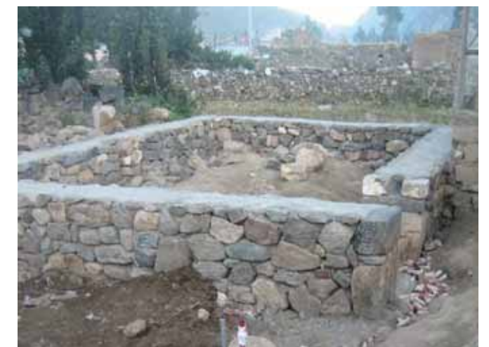
Avance de obra
