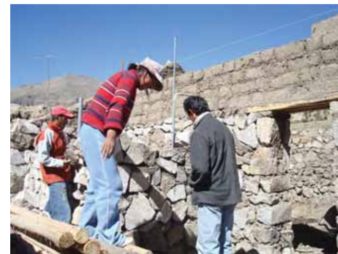
Avance de obra
