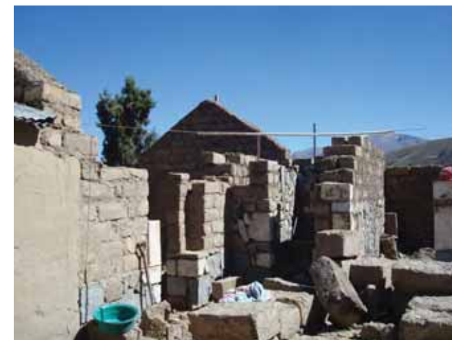
Avance de obra
