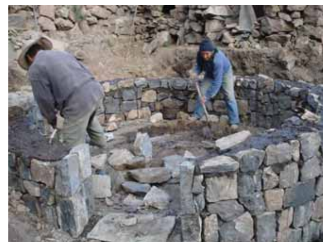
Avance de obra
