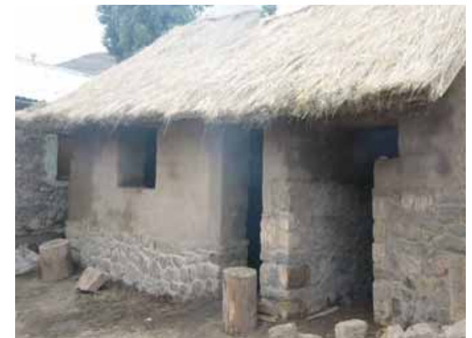
Avance de obra
