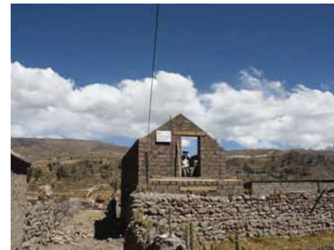
Avance de obra
