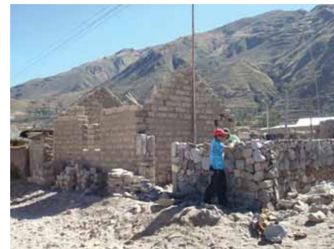
Avance de obra
