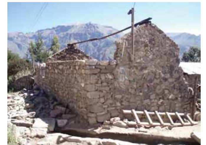
Avance de obra
