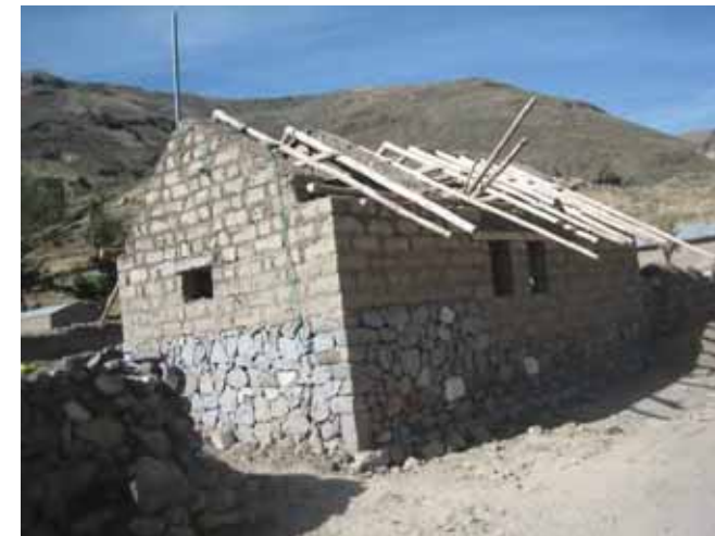
Avance de obra
