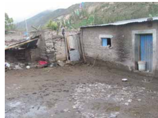
Avance de obra
