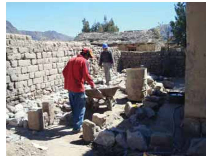
Avance de obra
