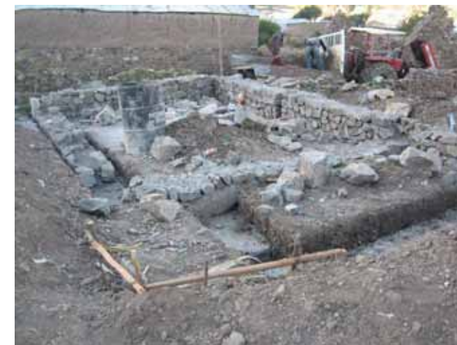
Avance de obra
