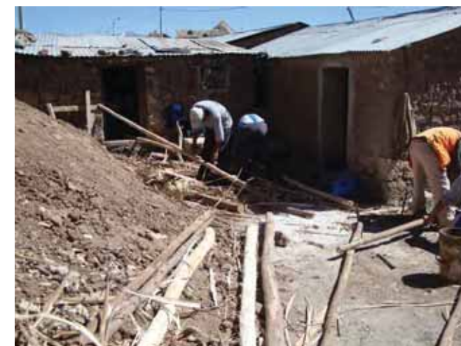
Avance de obra
