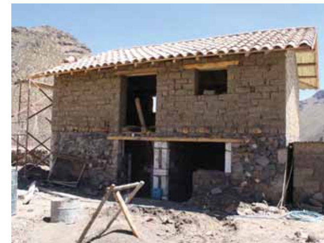
Avance de obra
