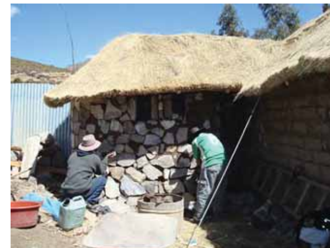
Avance de obra
