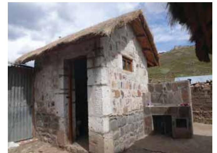
Servicios Higiénicos concluidos
