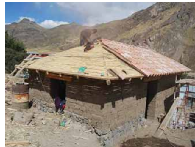
Avance de obra
