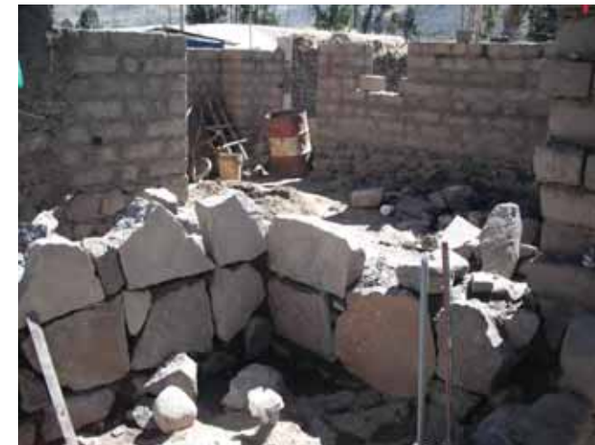
Avance de obra
