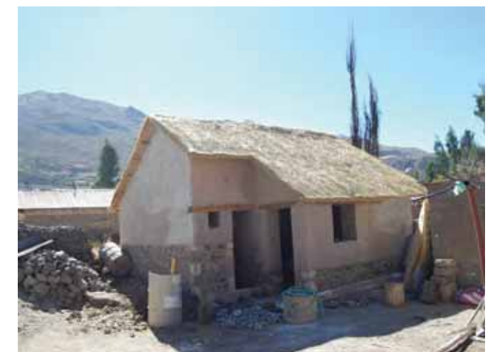
Avance de obra
