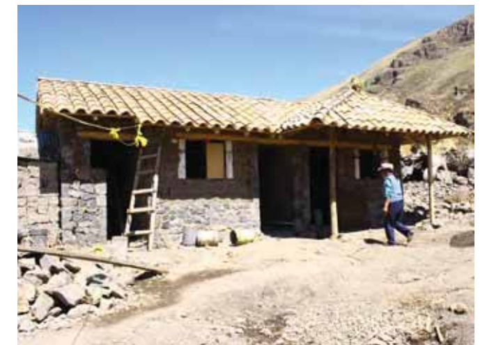
Avance de obra
