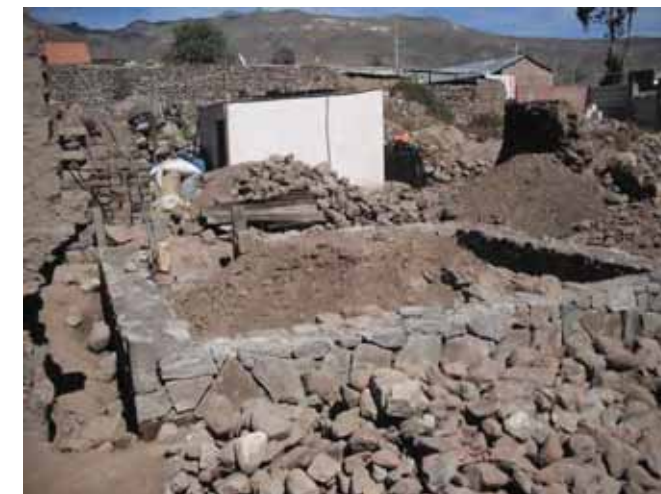
Avance de obra
