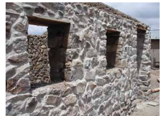
Avance de obra
