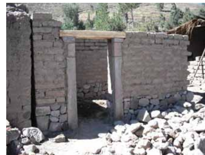
Avance de obra
