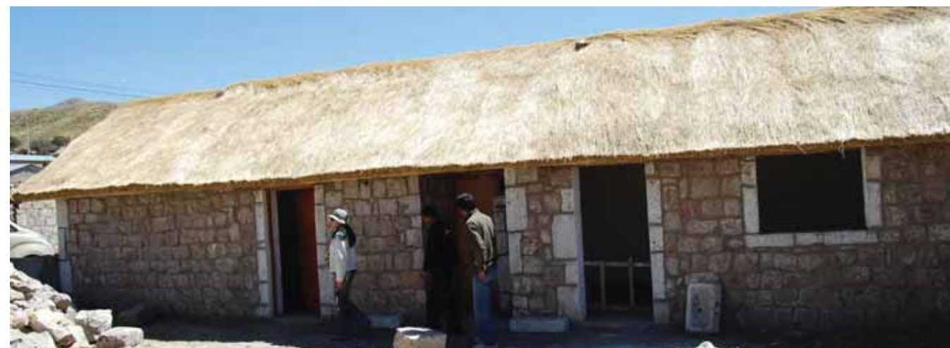
Avance de obra
