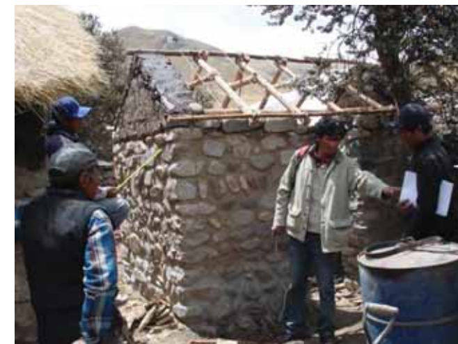
Avance de obra
