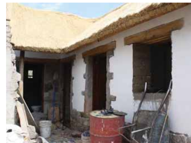
Avance de obra
