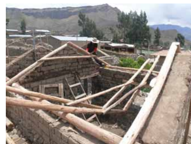
Avance de obra
