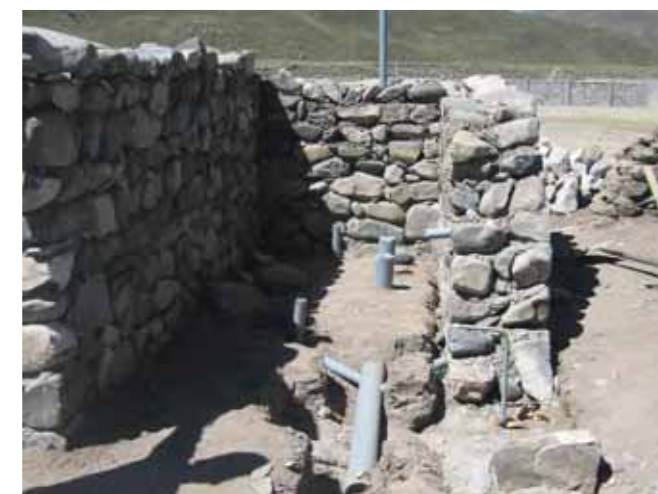
Avance de obra
