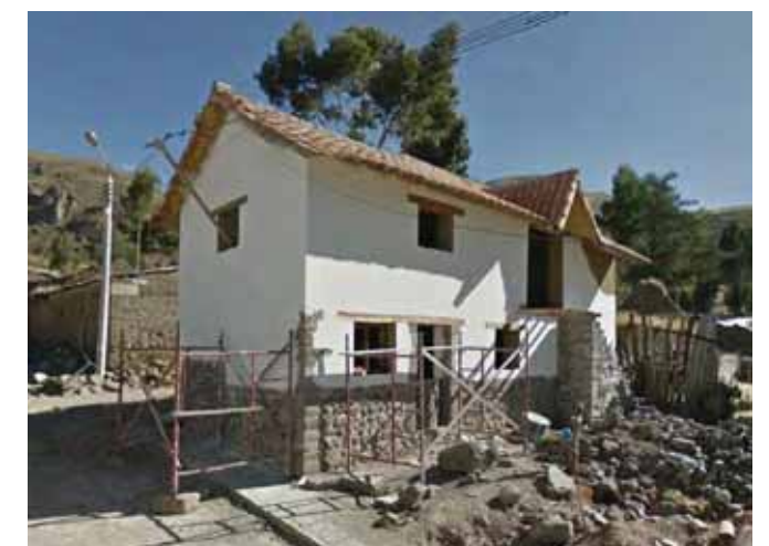
Avance de obra
