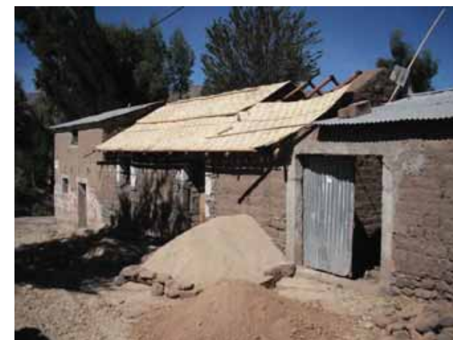
Avance de obra
