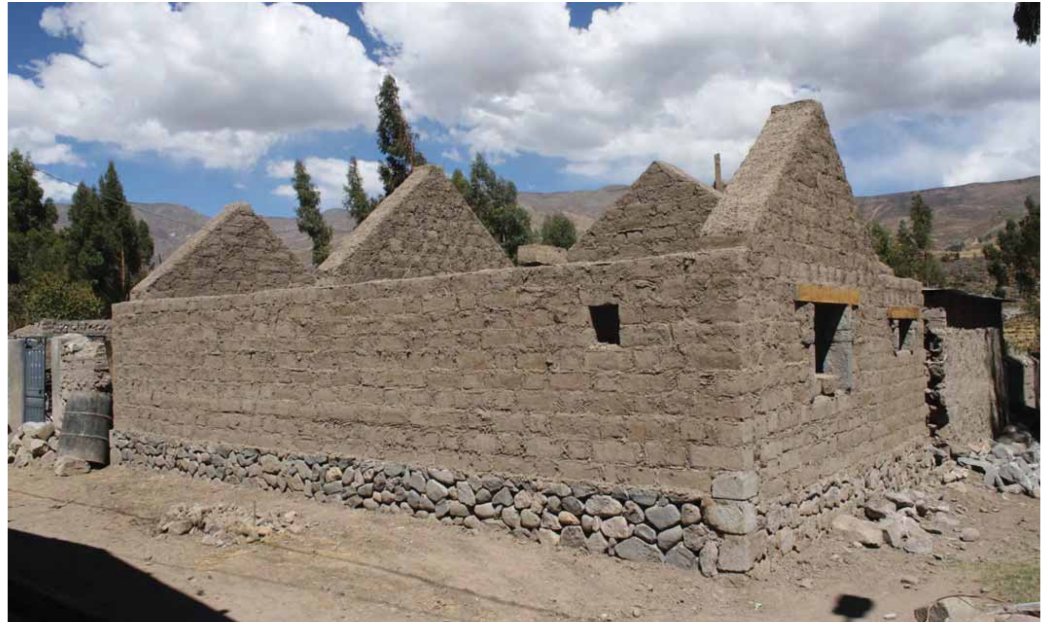
Avance de obra
