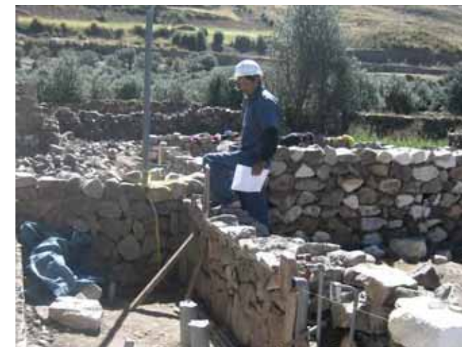
Avance de obra
