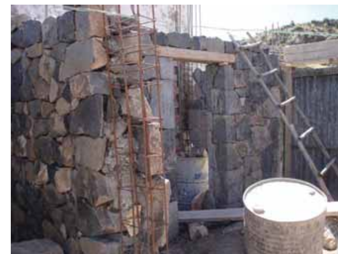
Avance de obra
