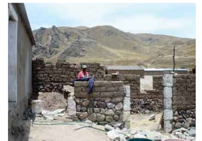
Avance de obra
