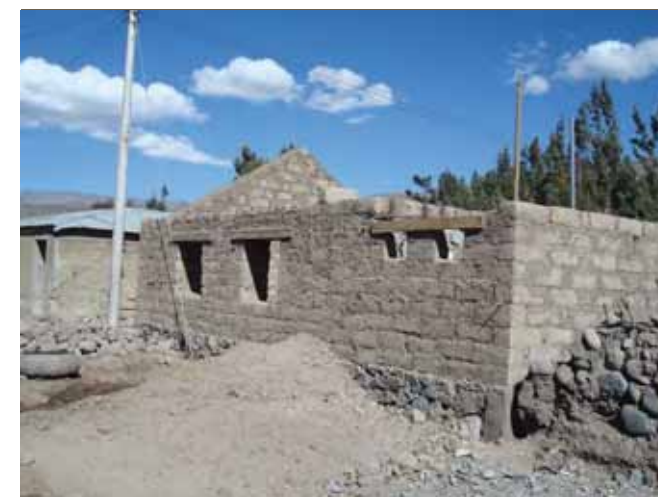
Avance de obra
