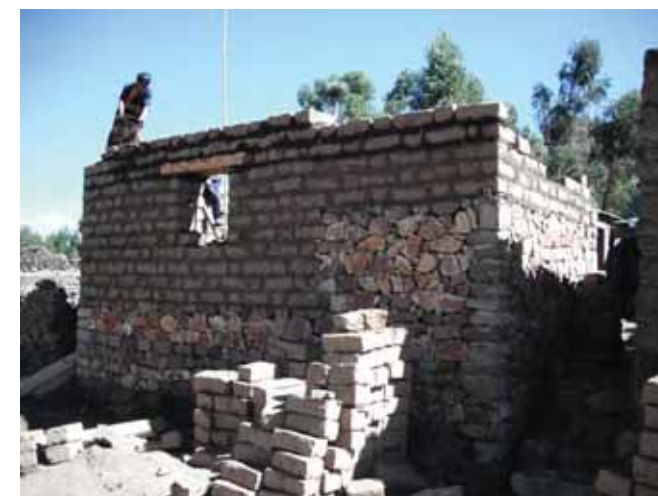
Avance de obra
