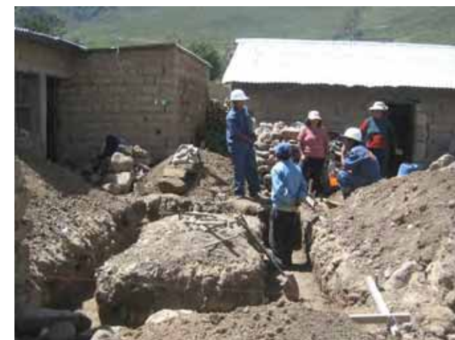
Avance de obra
