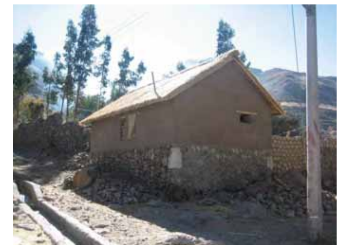
Avance de obra
