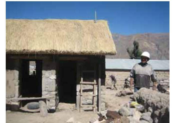
Avance de obra
