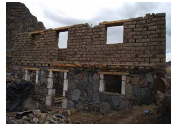
Avance de obra
