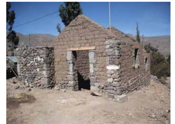
Avance de obra
