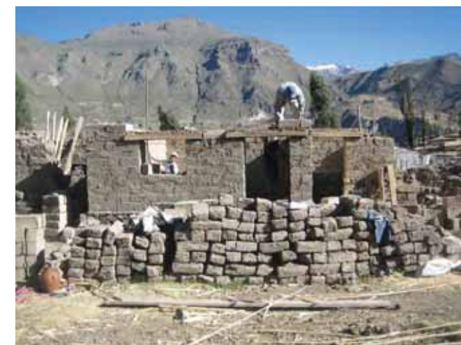
Avance de obra
