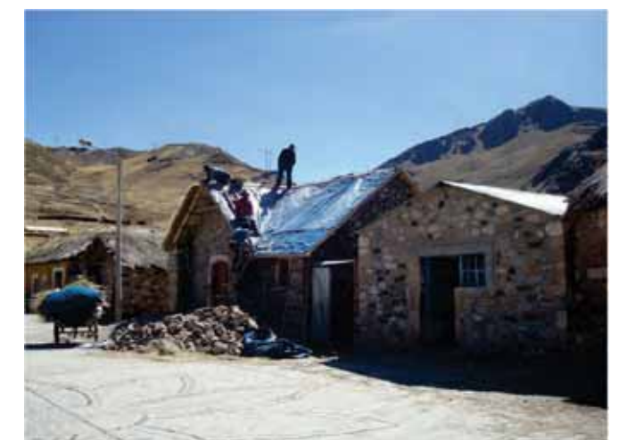
Avance de obra
