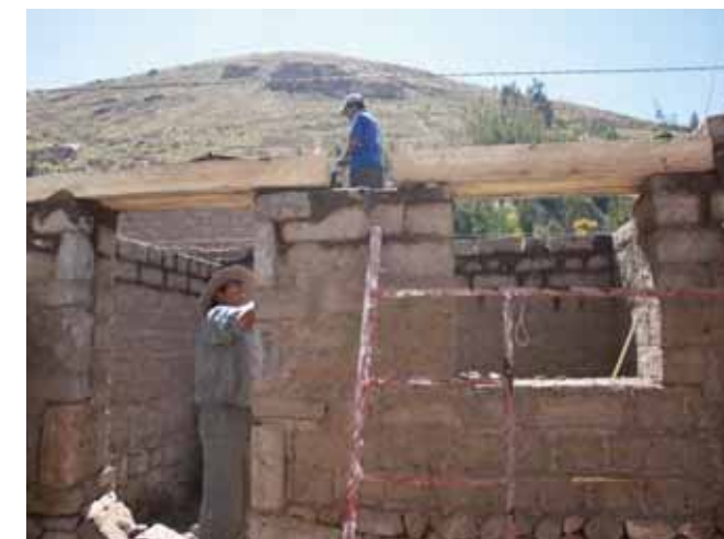
Avance de obra
