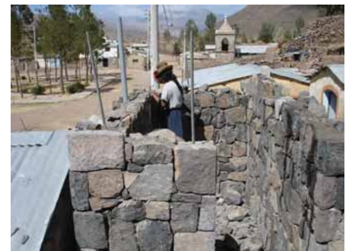
Avance de obra
