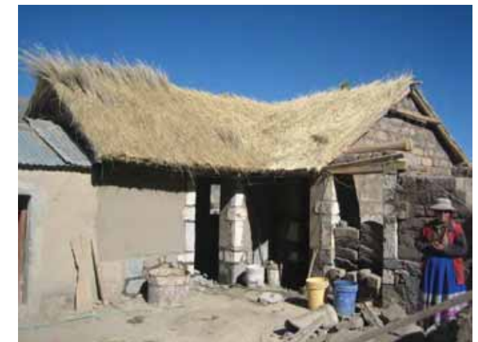
Avance de obra
