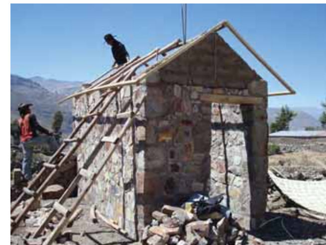
Avance de obra
