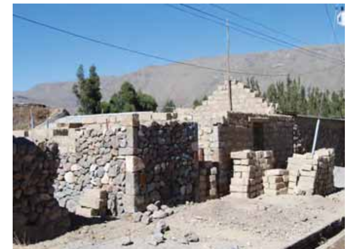
Avance de obra
