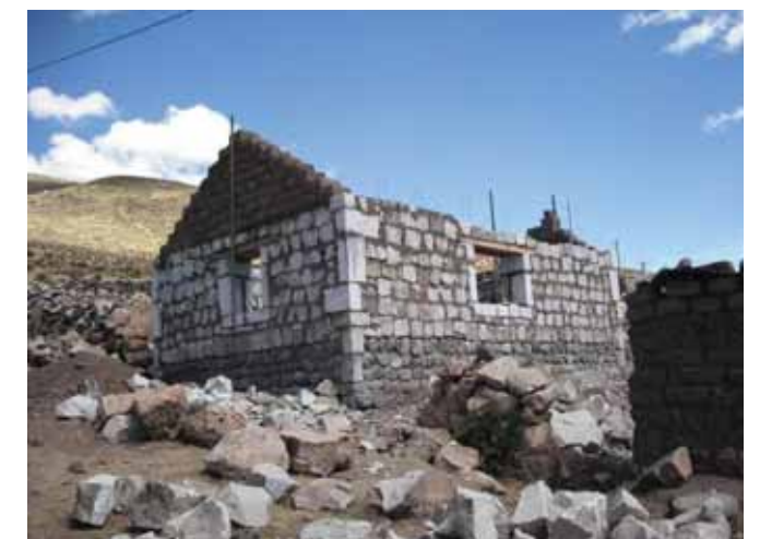
Avance de obra
