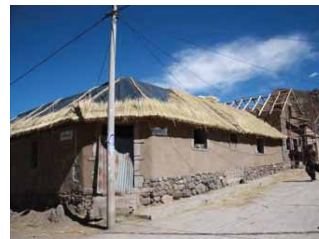
Avance de obra
