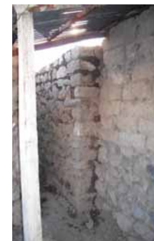
Avance de obra
