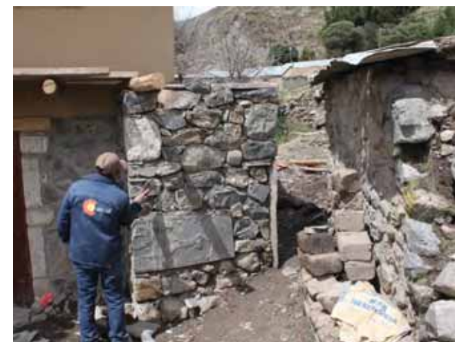
Avance de obra
