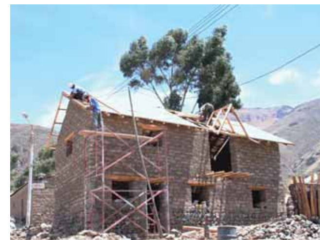
Avance de obra
