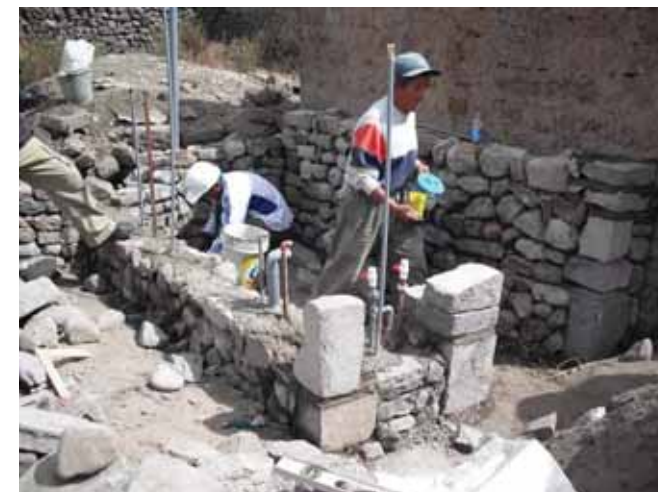
Avance de obra
