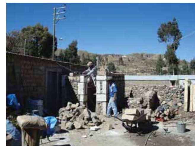
Avance de obra
