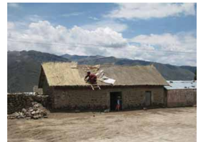
Avance de obra
