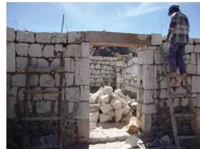
Avance de obra
