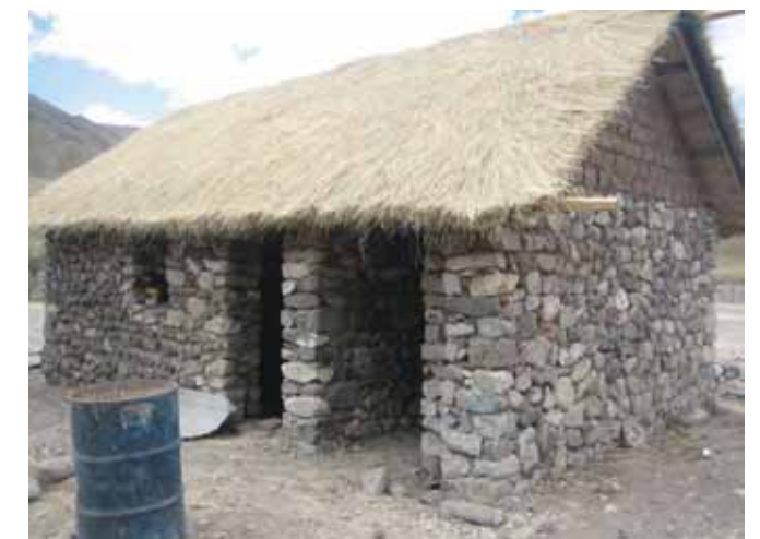
Avance de obra
