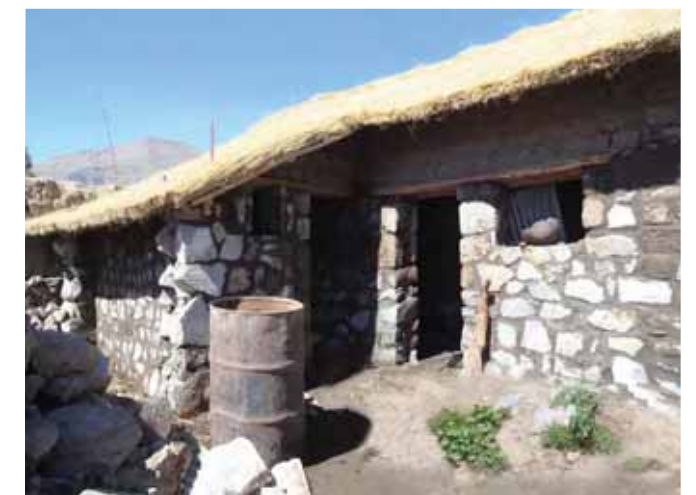
Avance de obra
