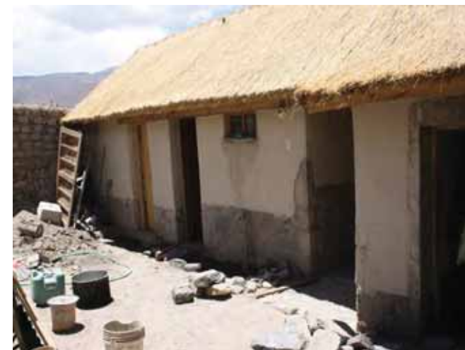
Avance de obra
