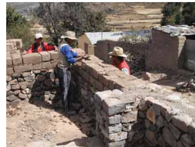
Avance de obra
