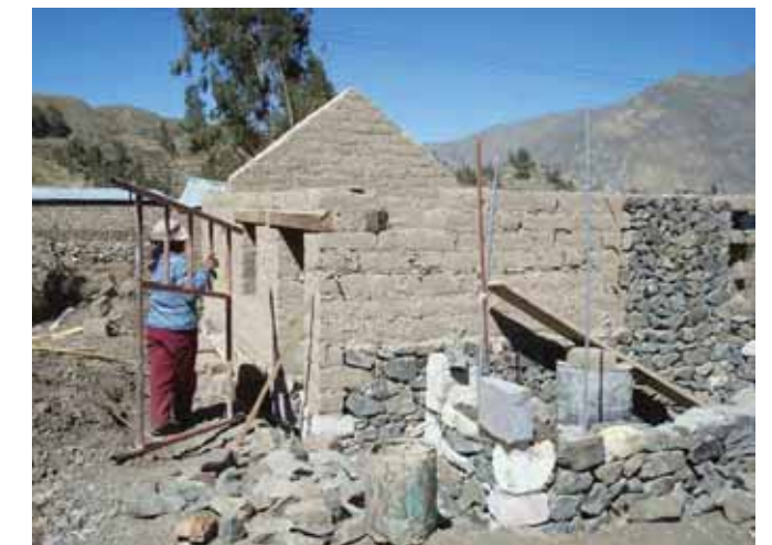
Avance de obra
