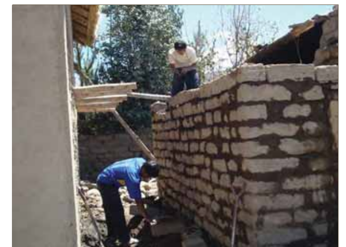
Avance de obra
