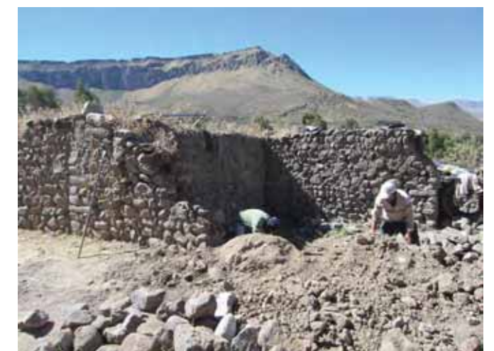
Avance de obra
