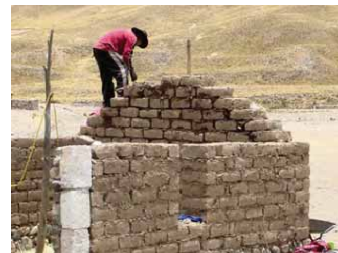
Avance de obra
