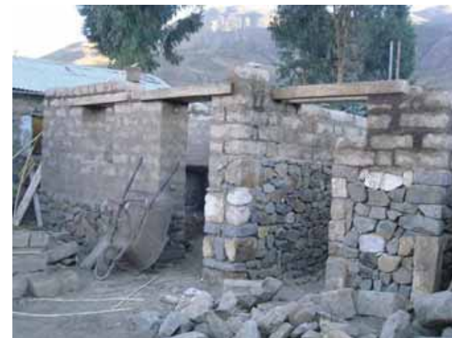
Avance de obra
