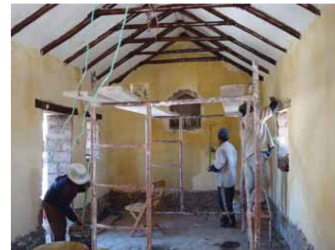
Avance de obra
