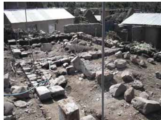
Inicio de obra
