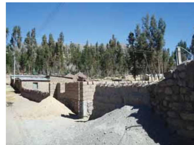
Avance de obra
