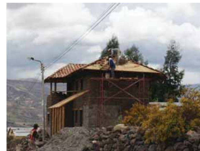
Avance de obra
