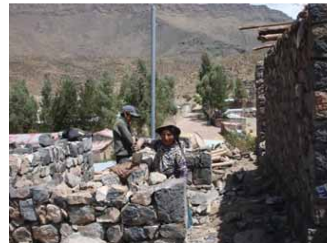
Avance de obra
