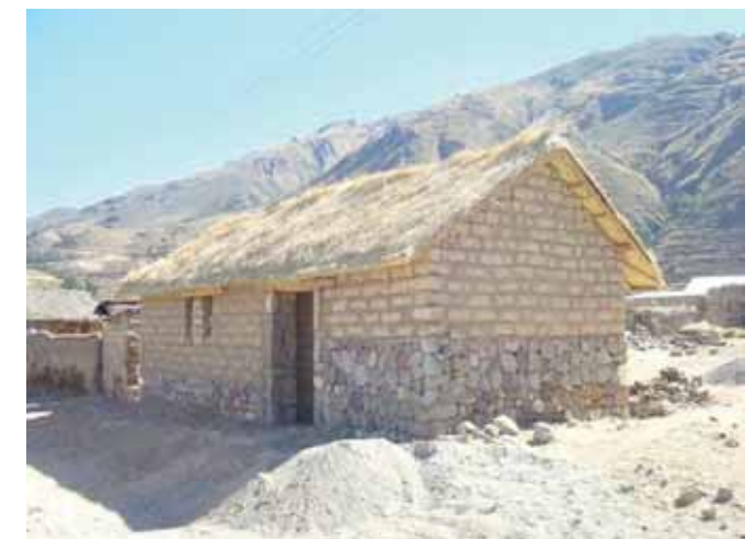
Avance de obra
