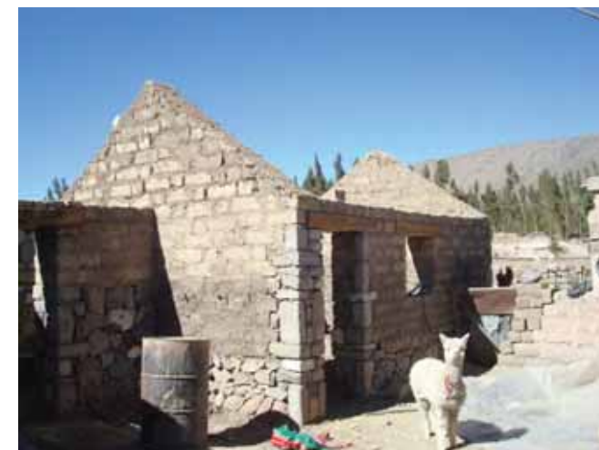
Avance de obra
