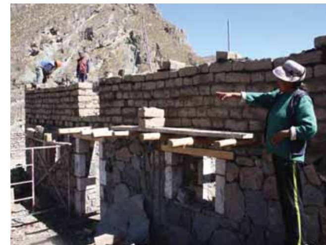
Avance de obra
