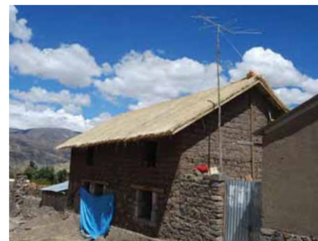
Avance de obra
