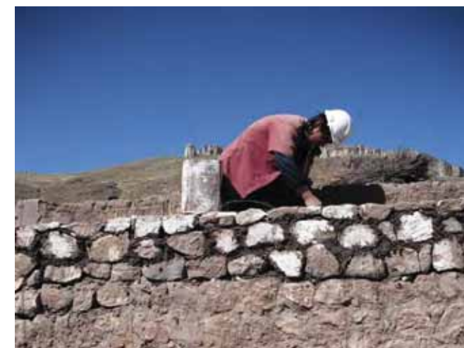
Avance de obra
