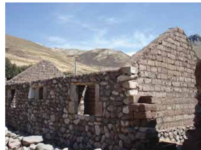
Avance de obra
