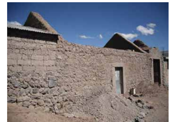
Avance de obra
