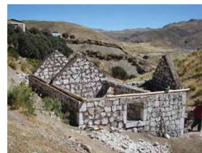
Avance de obra
