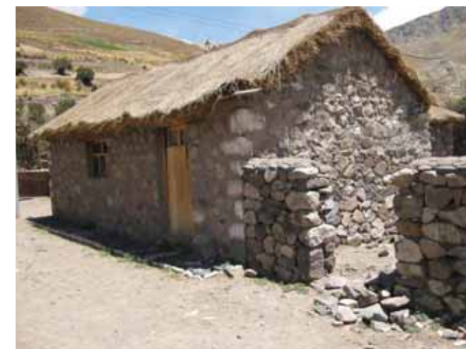
Avance de obra
