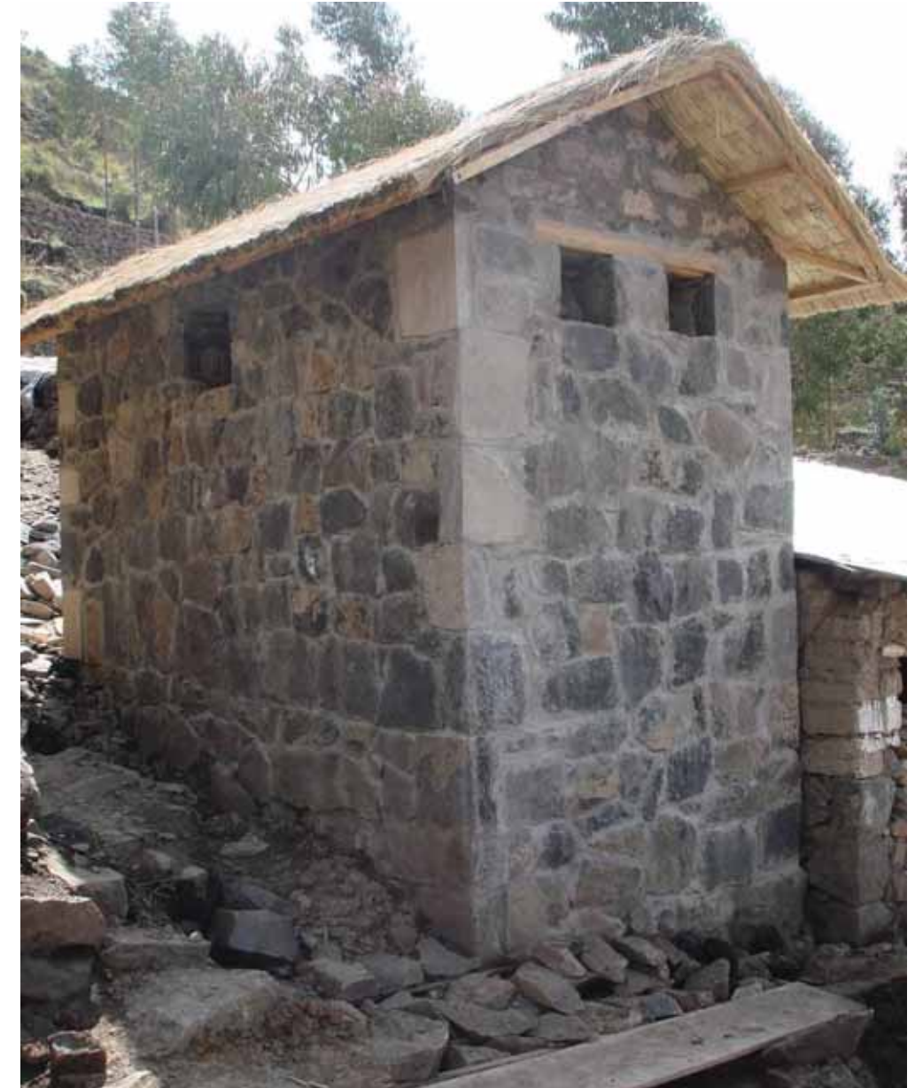
Servicios Higiénicos concluida
