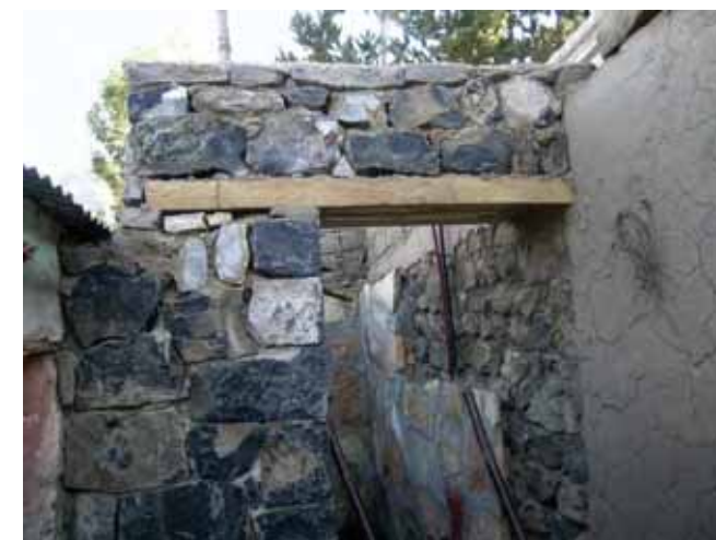
Avance de obra
