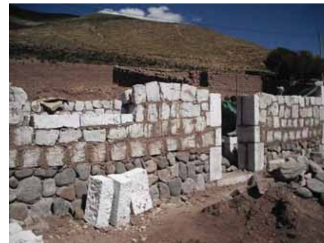
Avance de obra
