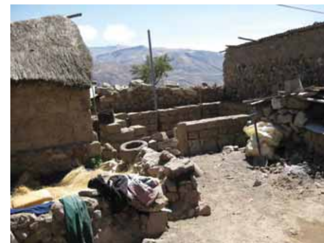
Avance de obra
