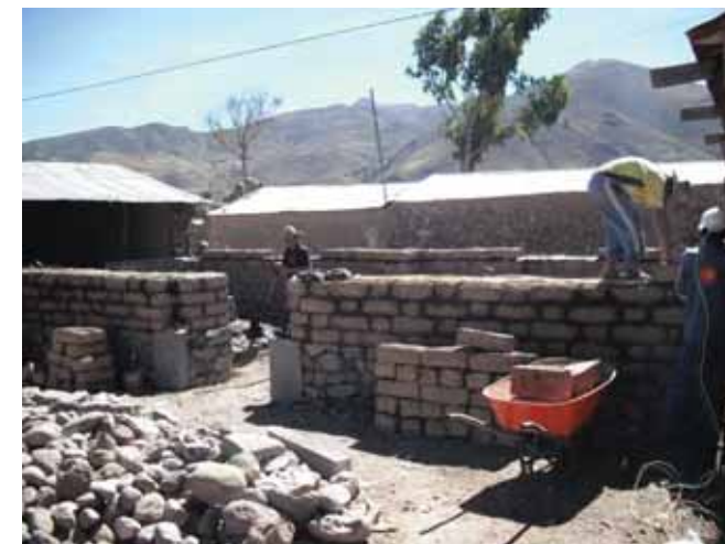
Avance de obra
