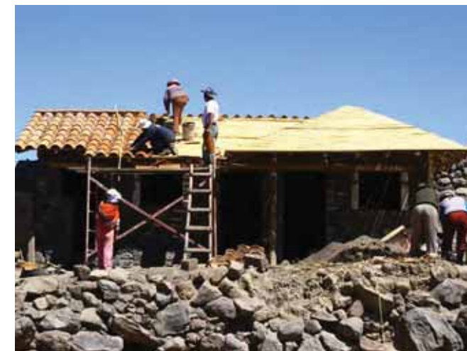
Avance de obra
