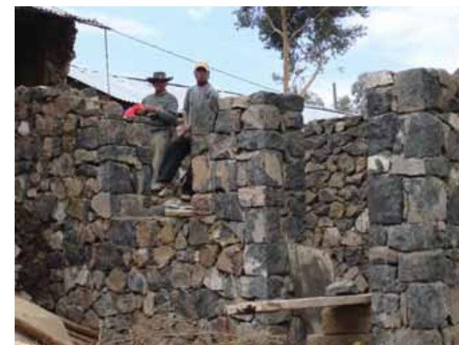
Avance de obra
