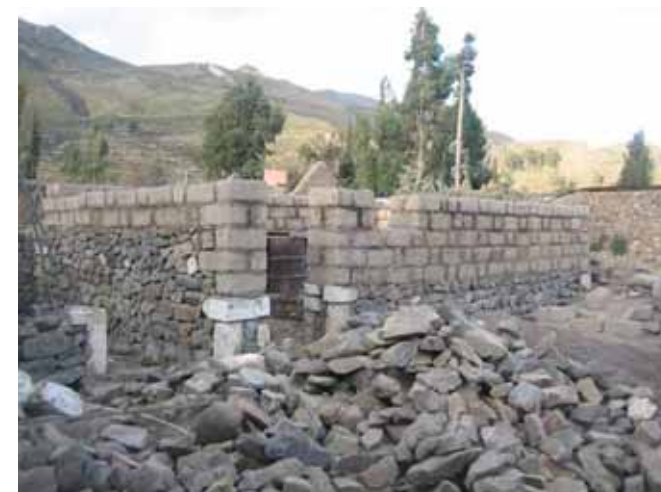
Avance de obra
