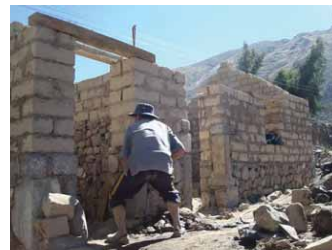
Avance de obra
