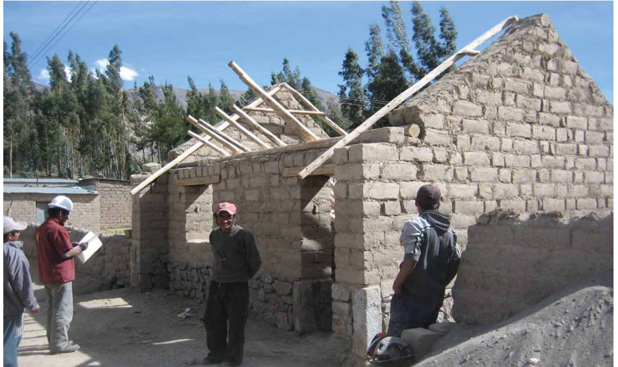
Avance de obra
