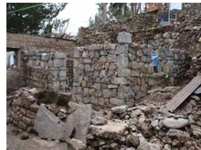
Avance de obra
