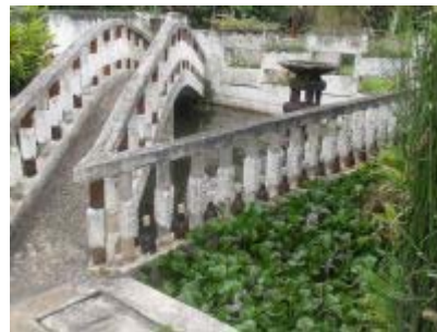
Puente de los suspiros sobre estanque de aguas tratadas.
