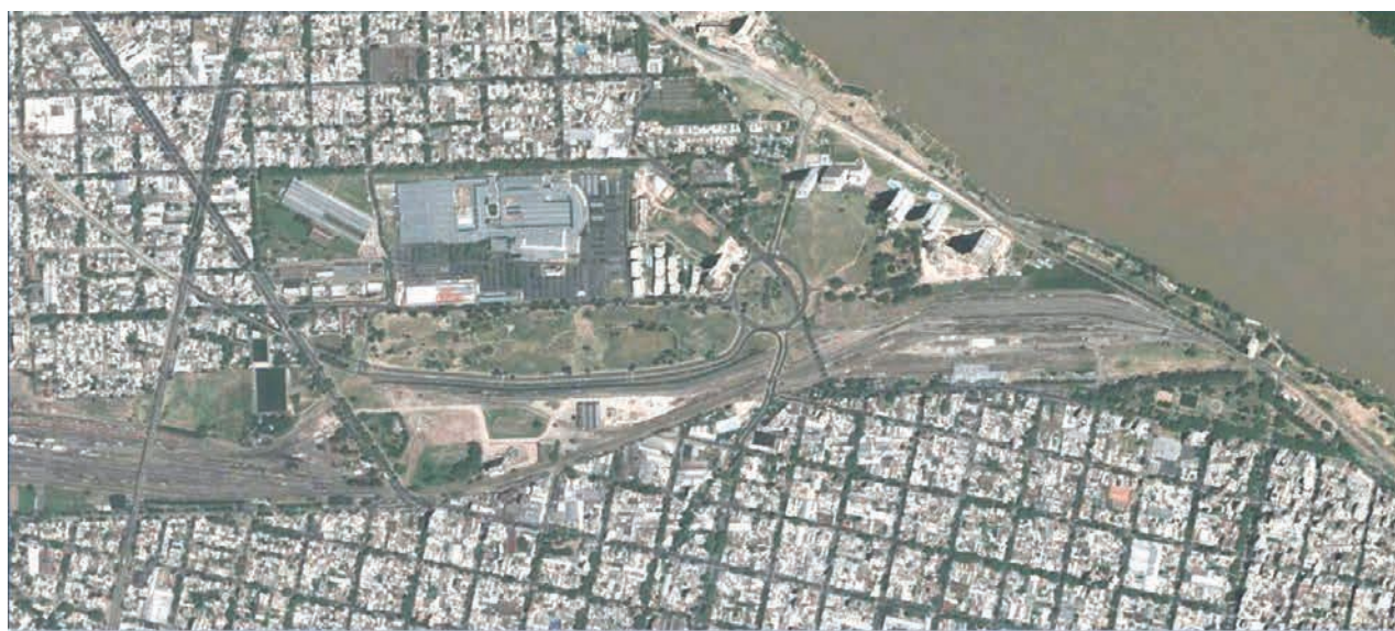
FIGURA 2.2. Vista general del área de renovación Scalabrini Ortiz – Puerto Norte
