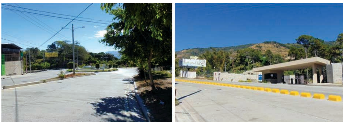
FIGURA A2.4. Vista actual del proyecto prolongación de la Alameda Juan Pablo II
