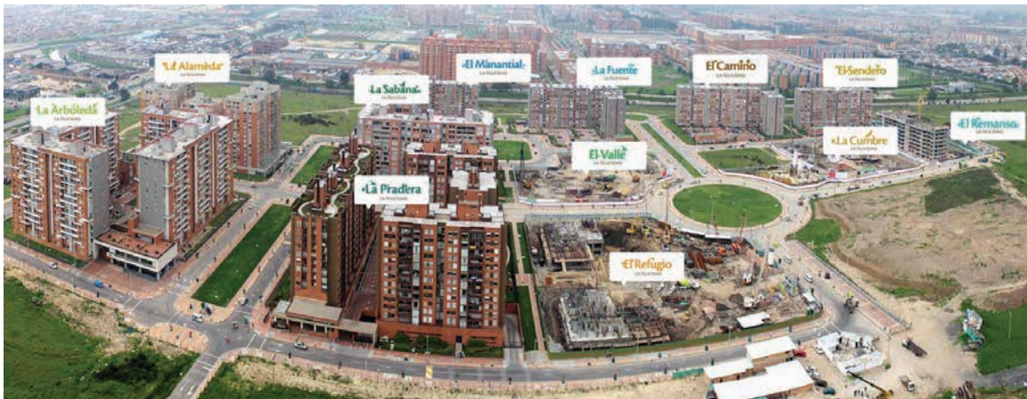
FIGURA 4.3. Avances de obra, abril de 2013
