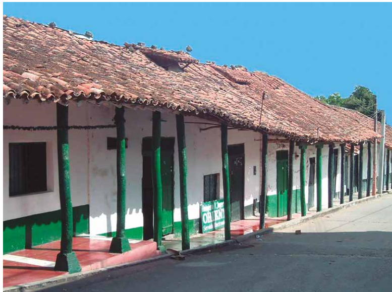
Figura 2.14. Ambalema. Pórticos típicos de las casas coloniales del Centro Histórico (2014)
