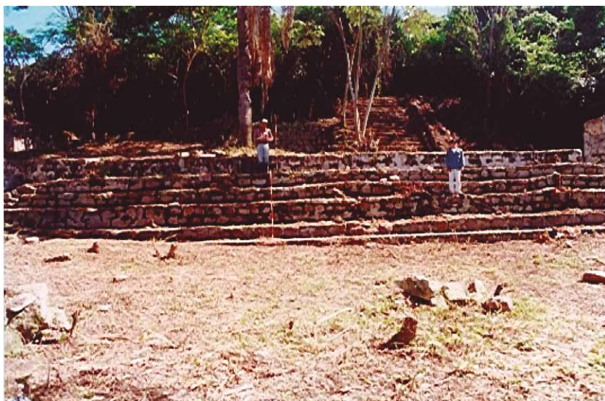
Figura 5.5. Escalonamiento de sustentación de las albercas
