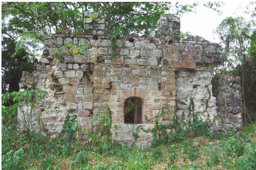
Figura 5.4. Edificación del cárcamo
