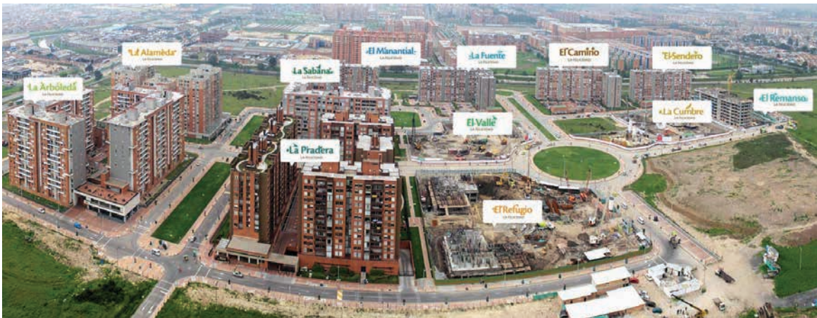
FIGURA 4.3. Avances de obra, abril de 2013
