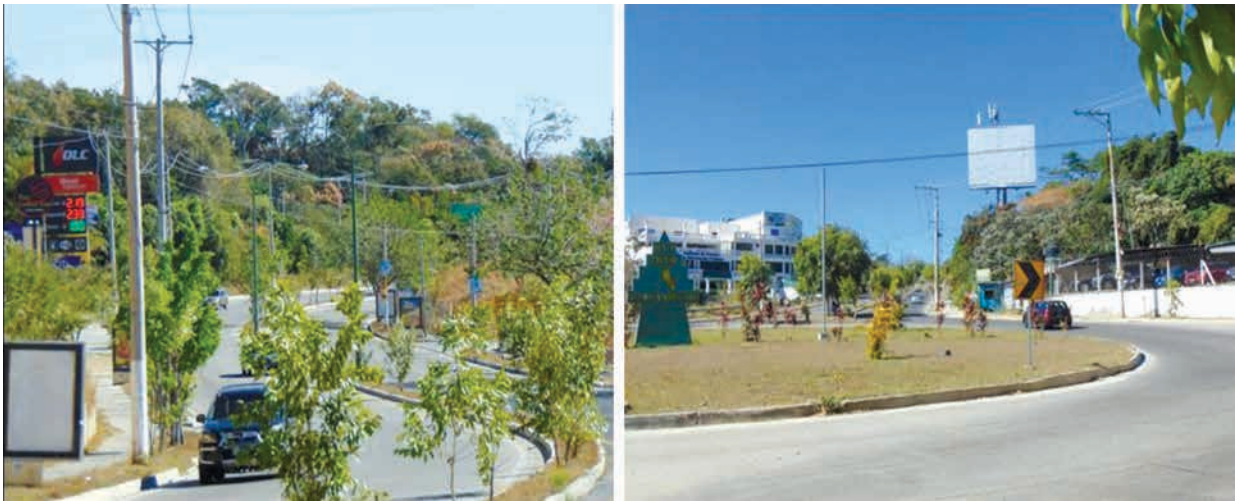
FIGURA A2.2. Vista actual de la zona del proyecto prolongación de la avenida Masferrer
