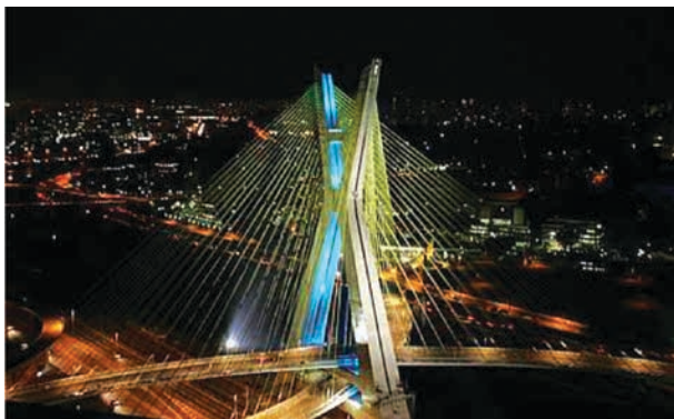
Foto: Puente Octávio Frias de Oliveira (São Paulo).
