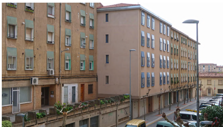
FIG.5./ Bloque rehabilitado entre bloques sin rehabilitar del Barrio de San Juan Bautista.
