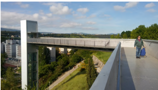
FIG. 5/ Ascensor en el barrio de Etxabakoitz (Pamplona)
