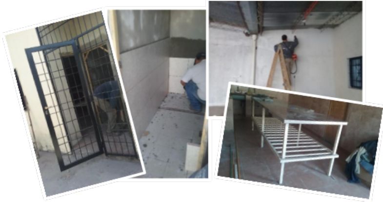
Imagen 2. Trabajos de mejoras en proceso. Fuentes: fotografía de autoría propia.
