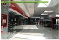
Adaptación del diseño arquitectónico de tiendas comerciales por contingencia sanitaria de la COVID-19
