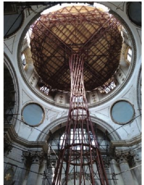
Figura 9. Proceso de montaje en diferentes períodos de las estructuras de acero que sirven de apoyo para la plataforma donde se apoyan los puntales para el apuntalamiento de la sección de la cúpula que no había colapsado y que aún se sostiene en las alturas. Fuente: Autor, agosto a octubre de 2020.
