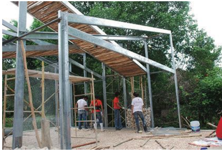
Figura 8. Capilla de Pedro Moreno, Quintana Roo, México, con sistema de muro a base de gavión confinado, aprovechando su disponibilidad de materiales de la región. Fuente: E.P., 2011.
