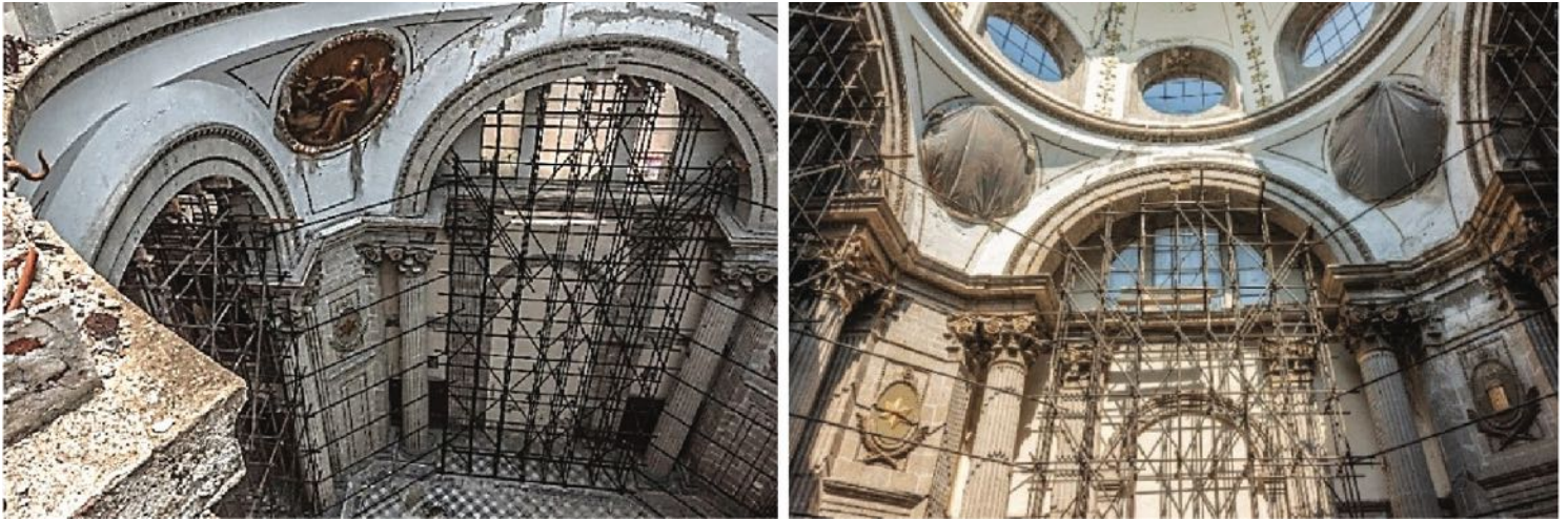
Figura 7. Fotografías donde se observan las primeras acciones de apuntalamiento de elementos estructurales en el transepto del santuario, y el desplazamiento de las claves de dos arcos y daños diversos en los elementos arquitectónicos. Fuente: Autor. Fotos: SACKBÉ, julio de 2019.
