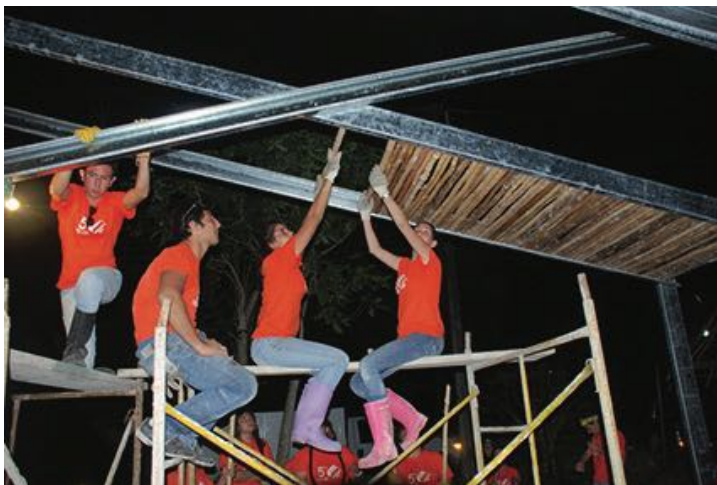
Figura 6. Conclusión de marcos y colocación de bajareque en tramos de techumbre. Fuente: E.P., 2011.
