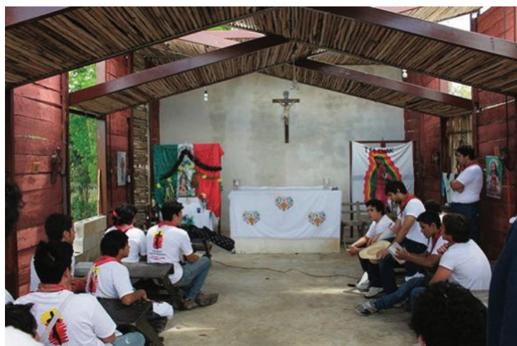
Figura 7. Capilla de Lázaro Cárdenas, Quintana Roo, México, con muros a base de tablonces de Palo de Tinte. Fuente: E.P., 2011.
