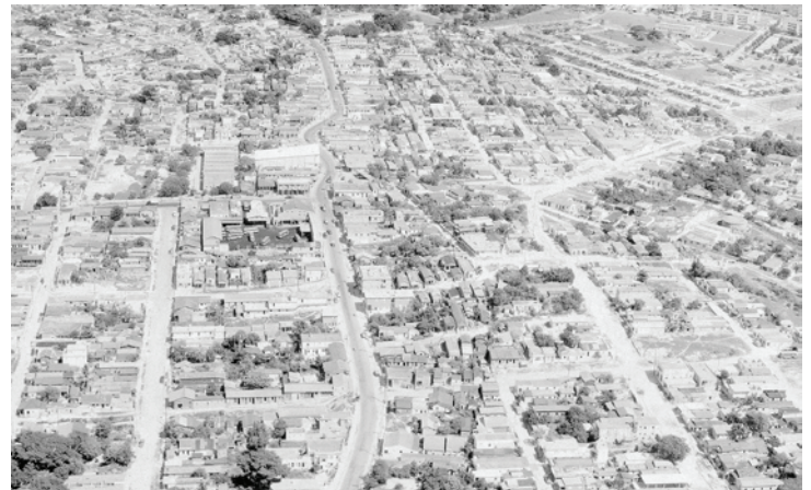
Figura 12. Calzada de San Miguel del Padrón, eje vial importante con servicios asociados a sus bordes. Fuente: Archivo fotográfico del Ministerio de Obras Públicas.
