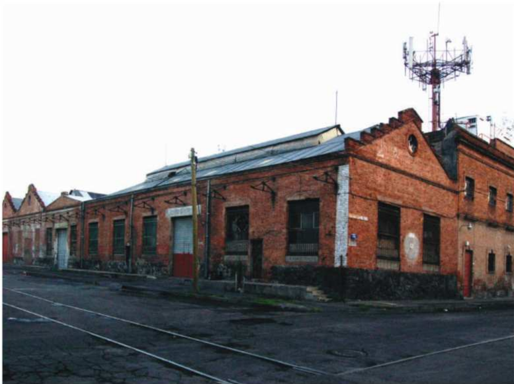
Figura 9. Bodegas de granos Elorduy, Heliotropo col. Atlampa. Se observan las espuelas para el arrastre de carros de ferrocarril. Fotografía: Armando Alonso, 2006
