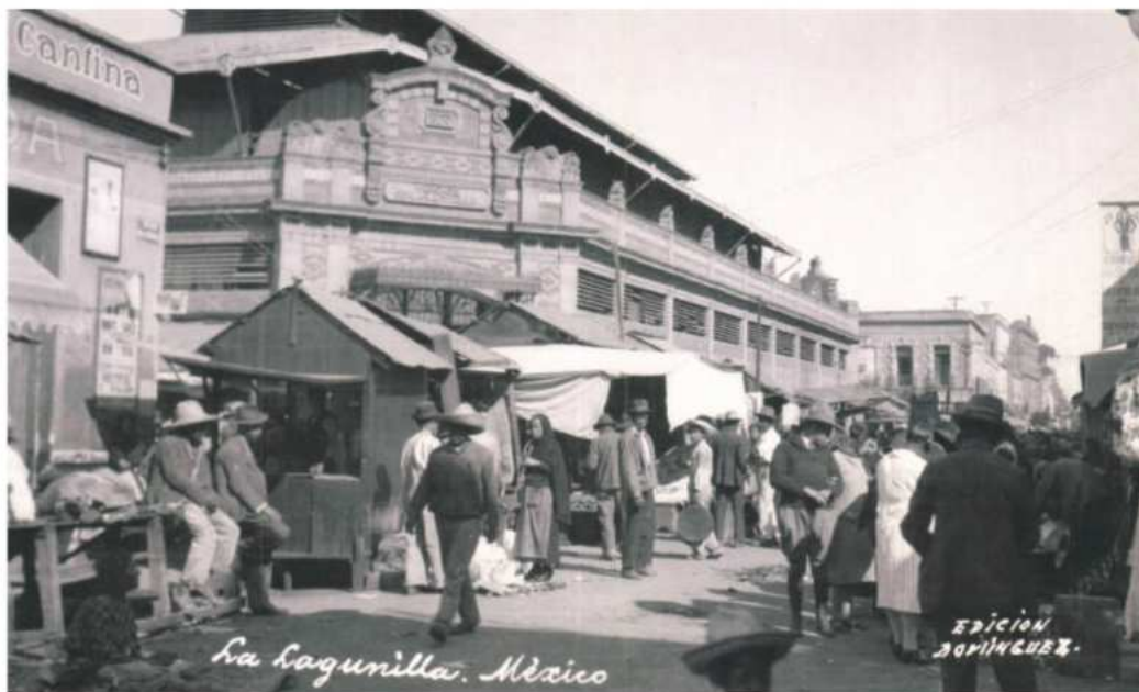
Figura 8. El antiguo mercado de la Lagunilla, en una fotografía cercana a 1930. En el sitio que ocupó el mercado, hoy se encuentra el Deportivo Guelatao. Colección Villasana.
