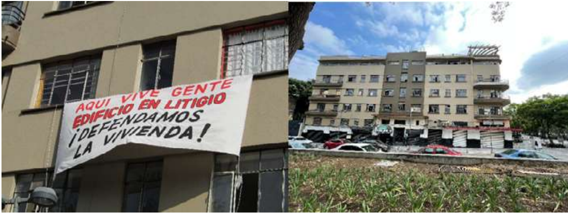
Figuras 2 y 3. Edificio Trevi, antes y después del desalojo. Fotos: V. Delgadillo 2029 y 2023.
