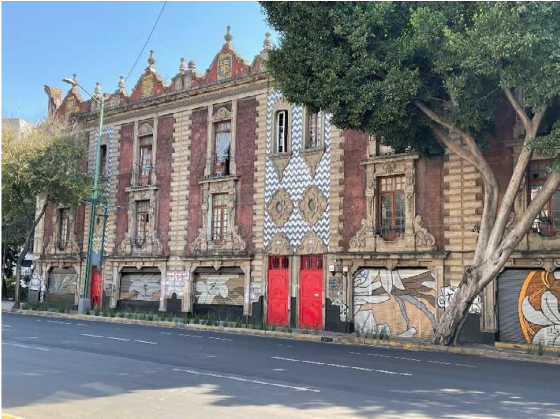
Figura 4. Edificio Gaona, desalojado. Foto: V. Delgadillo, 2023.
