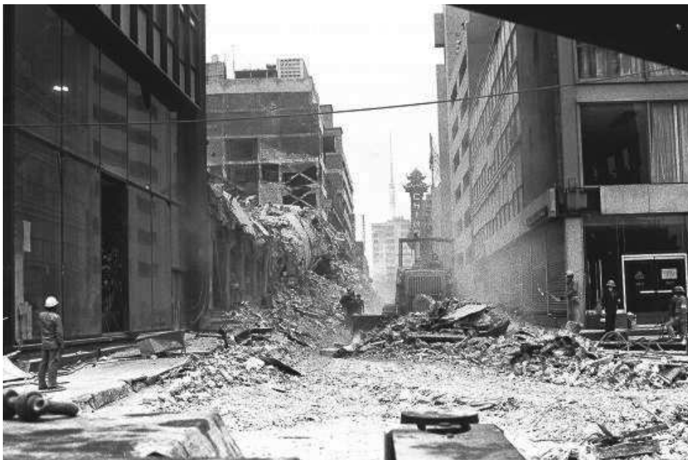
Figura N° 3 Daños del Distrito Federal de México, 1985
