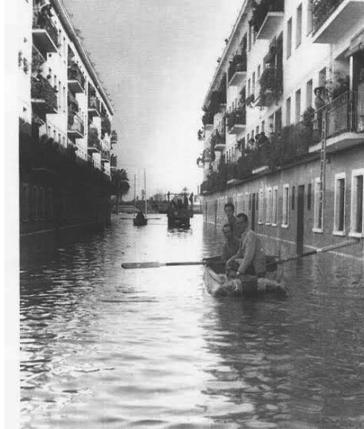
Figura N° 2 Inundación de una calle de Sevilla en 1961
