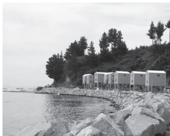
Figura N° 7 Dichato. Tipos de viviendas tipo palafitos, Sector Caleta Villarrica
